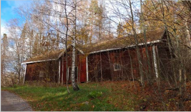
Hirsirakenteinen, pitkänurkkainen makasiinirakennus on mahdollisesti 1800-luvun alkupuolelta.
