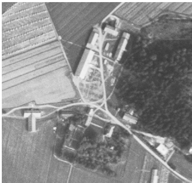
Vuoden 1938 ilmakuvassa (vasen kuva) näkyy kartanon pihapiiri. Osa rakennuksista on sittemmin purettu. Uudet rakennusalat on sijoitettu purettujen rakennusten paikoille (oikea kuva).
