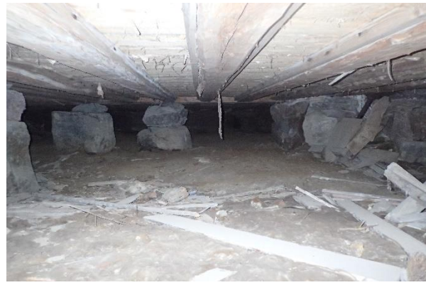
Kuva 4: Alapohjan rakenteellisessa kunnossa ja tuuletuksessa ei havaittu puutteita.
