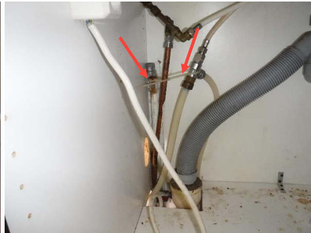
Kuva 26: Uudempaa muoviputkea kannakoitu nippusiteellä vanhaan putkeen.
