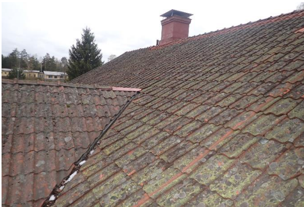
Kuva 15: savitiilikatteen pinnassa havaittiin varsin runsaasti sammalta.
