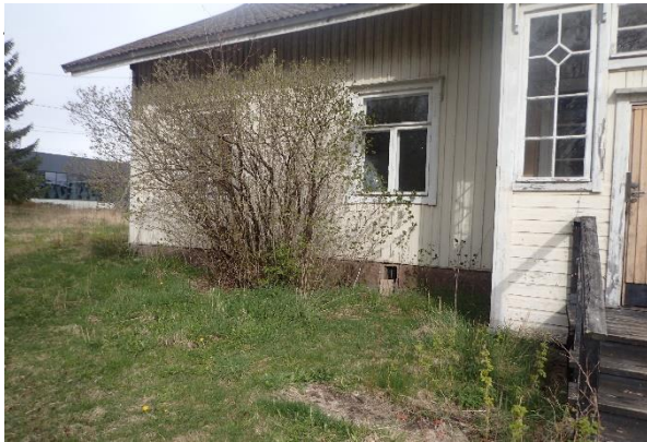
Kuva 1: Pinnat rakennuksen ympärillä ovat joko tasaiset tai ne kallistavat lievästi rakennuksesta poispäin.
