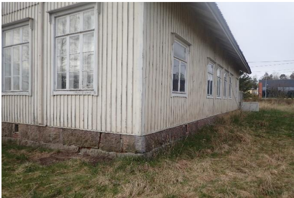
Kuva 3: Rakennuksessa on luonnonkivisokkeli.
