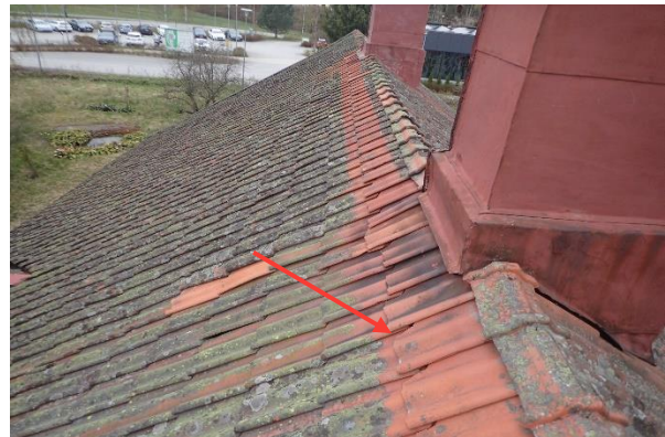
Kuva 16: Savitiilikatteessa havaittiin varsin paljon rikkoutuneita kattotiiliä.
