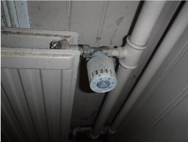
Kuva 23: Patteritermostaatit ovat asennusvuodelta 1977.
