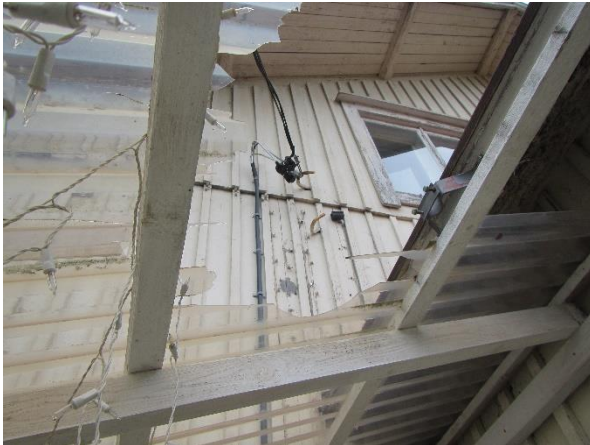
Kuva 40: Näkyvä liittymiskaapelista
