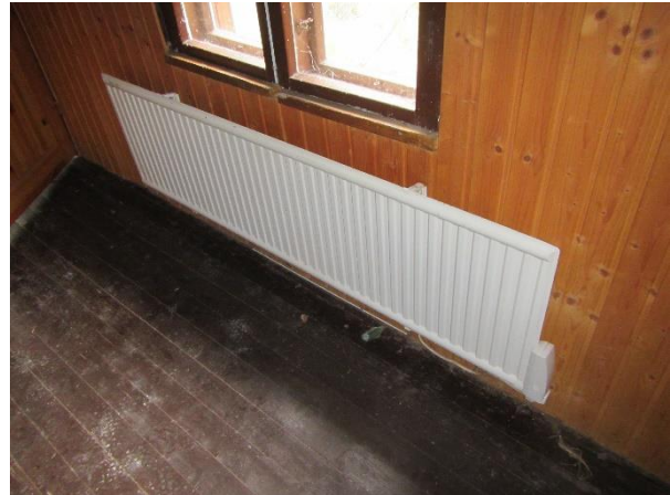
Kuva 50: Näkymää sähkölämmityspatterista
