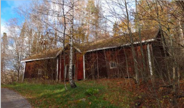
Hirsirakenteinen, pitkänurkkainen makasiinirakennus on mahdollisesti 1800-luvun alkupuolelta.
