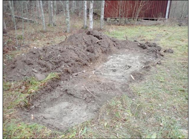
Kuva 20. Koekuopan 2.1 eteläpuolelle kaivettu koeoja 2.15 koilliseen kuvattuna. Ojan keskellä näkyvä vaalean ruskea hiekka on täyttökerrosta.
