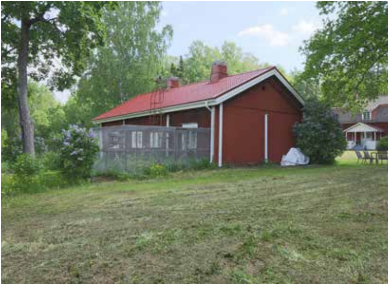
← Sivurakennuksen etelän- ja lännenpuoleiset julkisivut.
