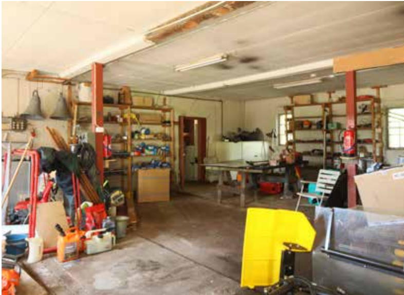
← Pajarakennuksen ensimmäisen kerroksen suurin sisätilä. Lattiassa on nähtävissä purettujen väliseinien hirsirakenteita.
