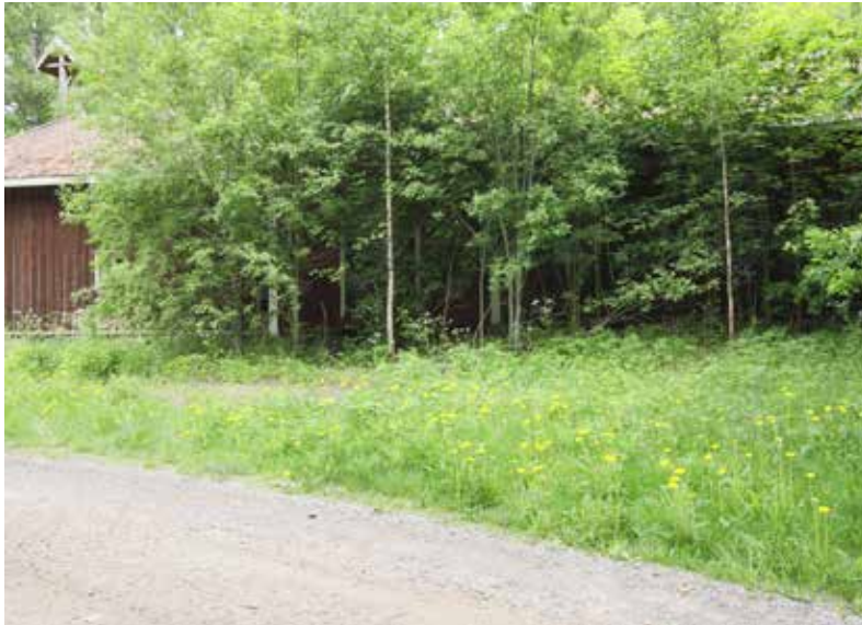
← Makasiinirakennuksen eteläisivun itäosa on paljolti kasvillisuuden peitossa.
