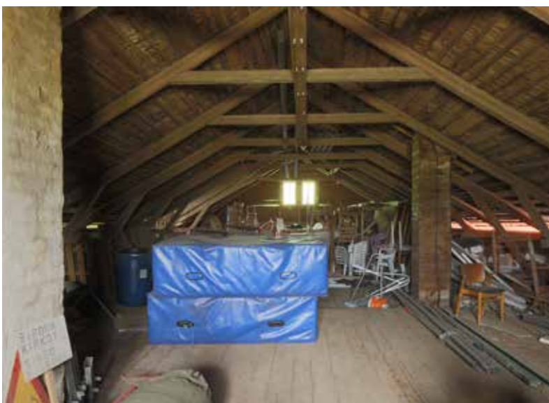
← Pajarakennuksen ylin on yhtenäistä tilaa.
