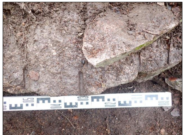
Kuva 44. R6.1. Porausia rakenteen eteläisivun kivessä.
