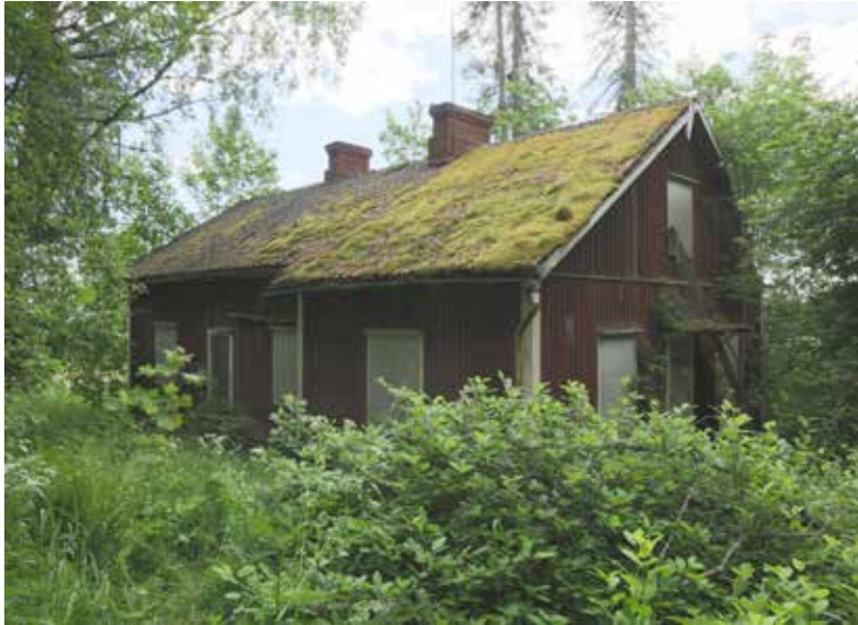
← Autioitunut asuinrakennus, pohjoisen ja lännen puoleiset julkisivut.
