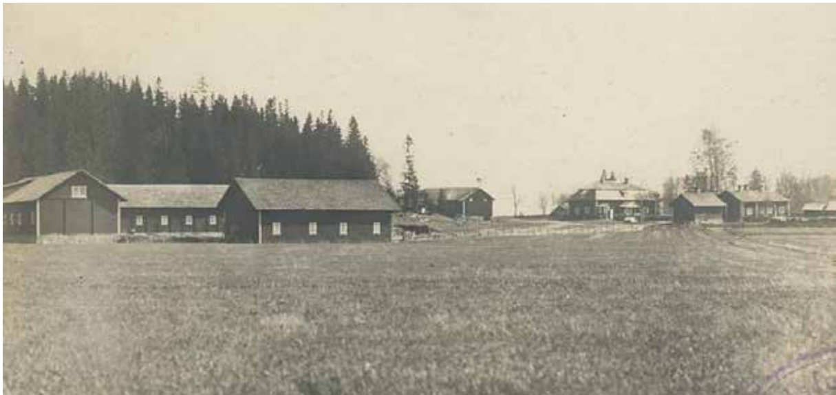
↑ Nikkilän kartano vuonna 1909. Uusi talouspiha vasemmalla, keskellä makasiinirakennus ja oikealla asuinpiha, jossa maakellari, pääarakennus, meijerinä toiminut rakennus, kartanon sivurakennus sekä jokin muu rakennus tai mahdollisesti kaksi aittaa. Kuva: Sibbo hembygdsförening rf.
