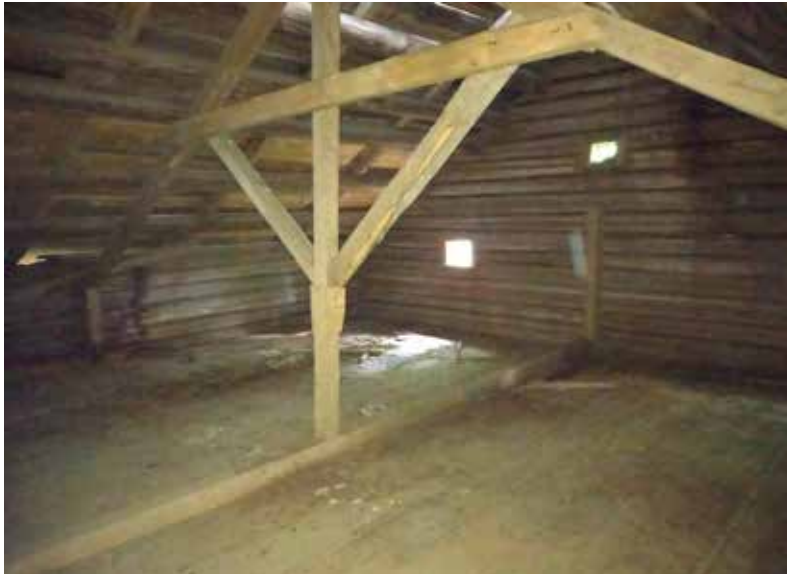
← Makasiinirakennuksen toista kerrosta.
