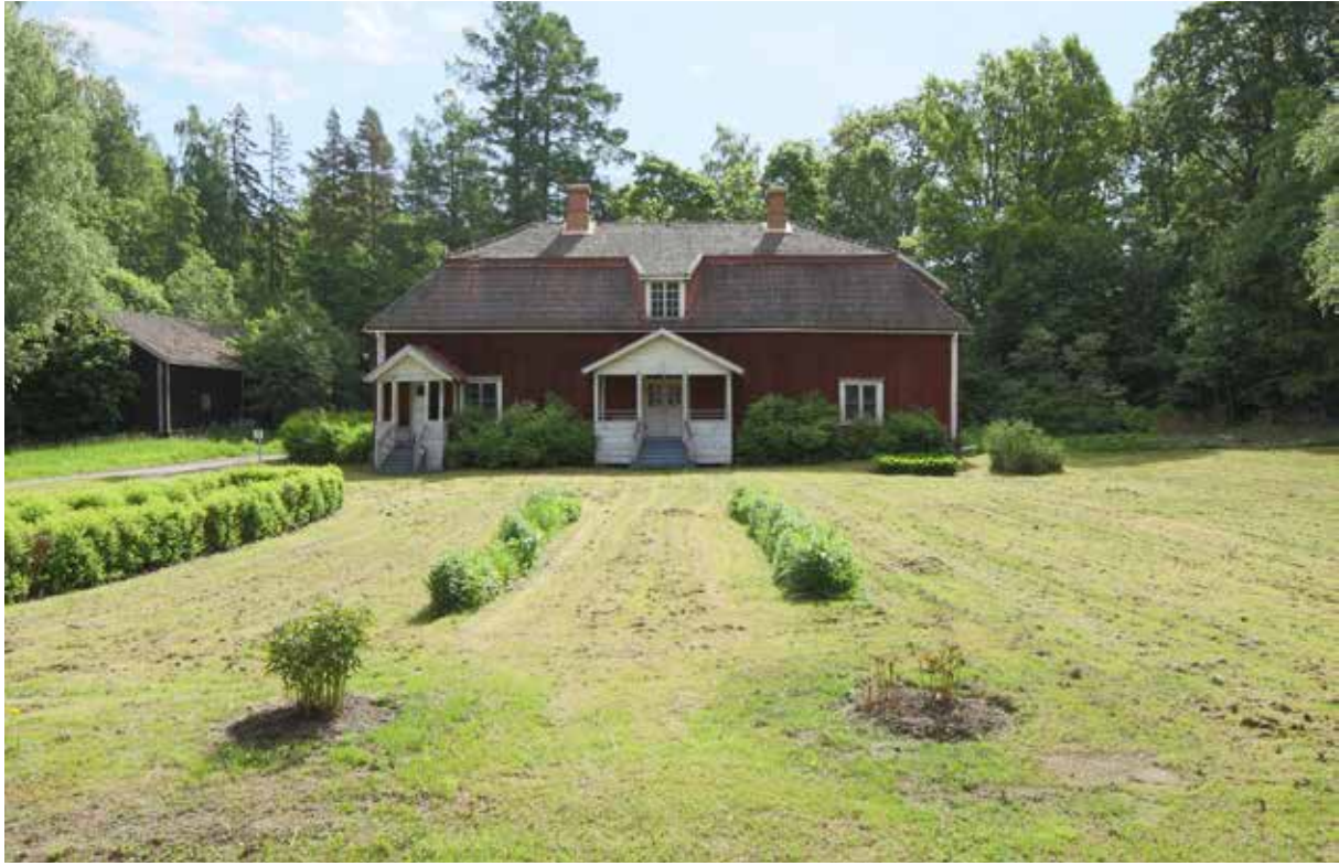
↑ Kartanon päärakennus kuvattuna lännestä. Vasemmalla näkyy makasiinirakennus.
