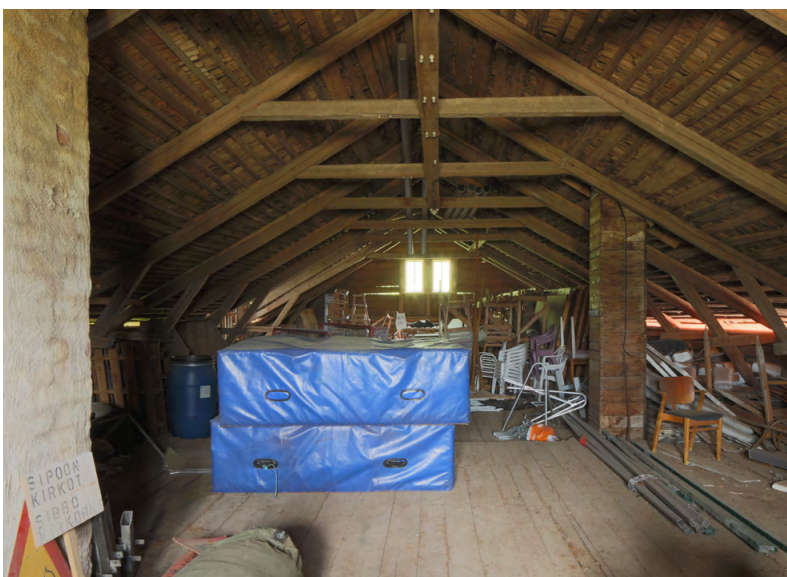
← Pajarakennuksen ylin on yhtenäistä tilaa.
