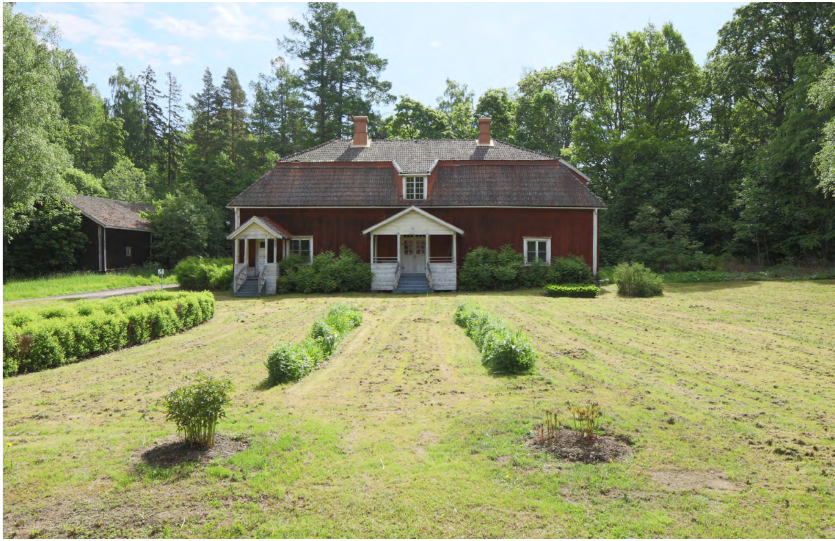
↑ Kartanon päärakennus kuvattuna lännestä. Vasemmalla näkyy makasiinirakennus.
