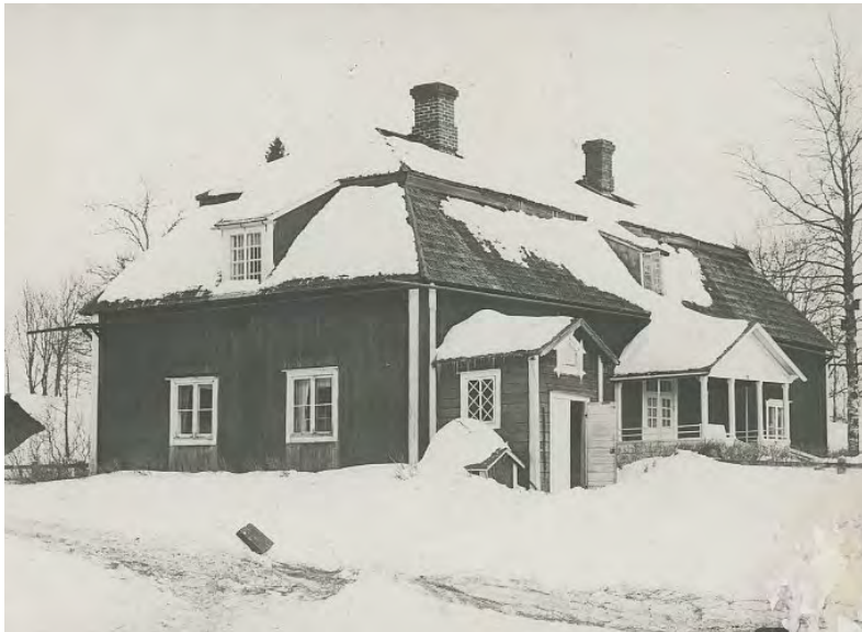
← Talvisessa kuvassa vuodelta 1926 päärakennuksessa on pärekatto. Rakennukselle tunnusomaista on taitettu aumakatto. Sibbo hembygdsförening rf.
