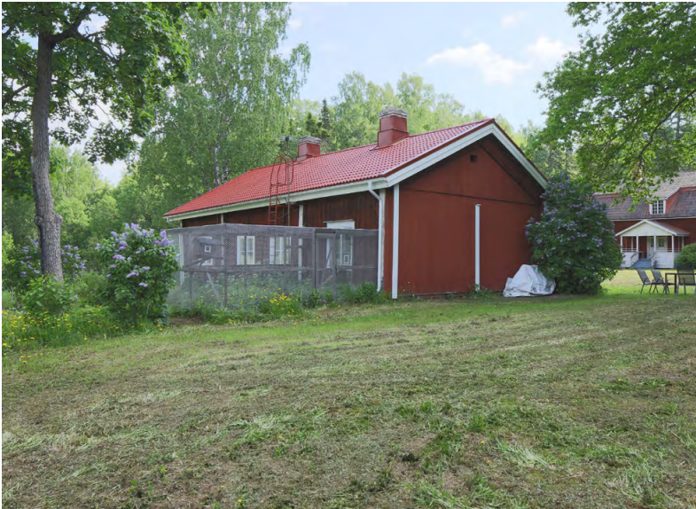
← Sivurakennuksen etelän- ja lännenpuoleiset julkisivut.
