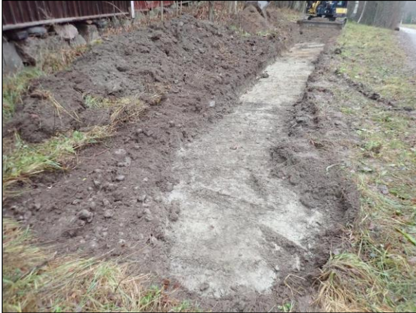
Kuva 19. Koillisosan ladon eteläpuolelle kaivettu koeoja itään kuvattuna. Vasemmassa reunassa olevat mukulakivet olivat osa muokkauskerrosta.
