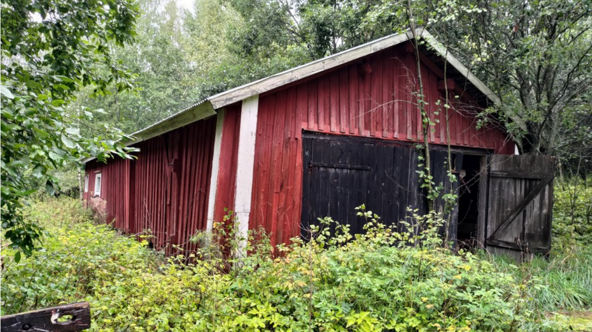
Kuva 5. Tallin ja puuvajan yhdistelmä rakennus,
