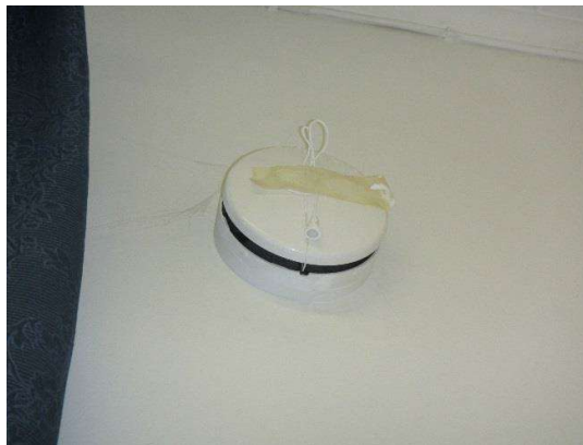
Kuva 82. Korvausilmaventtiili
