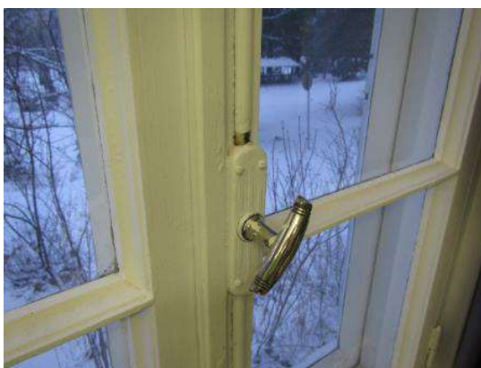
Kuva 34. Espanjolettien pitkittäistangot ovat maalattu yli, joka heikentää käyntiä.
