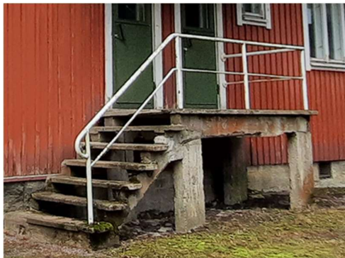
Vaurioituneet betoniportaajat
