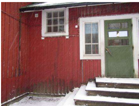
Kuva 38. Pääsisäänkäynnin puinen ovi.
