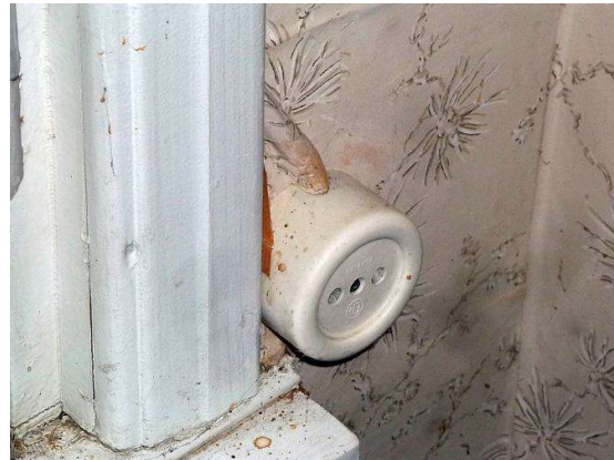
Kuva 91. 0-luokan pistorasia. Sallittu edelleen vaarattomissa olosuhteissa (mm. >4 m maadoitetuista rasioista).
