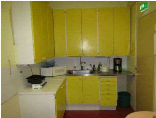
Kuva 59. Vanhan keittiön kaapit ovat paikoillaan, vasemmasta reunasta on purettu liesituuletin ja hella.
