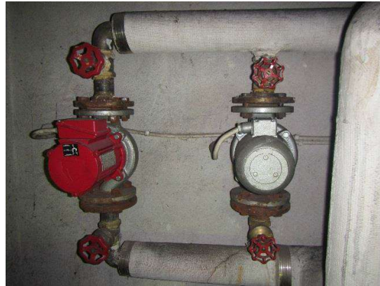
Kuva 64 Lämmitysverkoston kiertopumput
