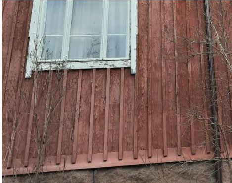
Ulkoseinä – sokkeliinliittymän pellitys
