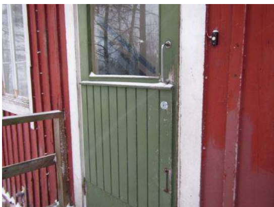
Kuva 37. Vanha puurakenteinen ulko-ovi.
