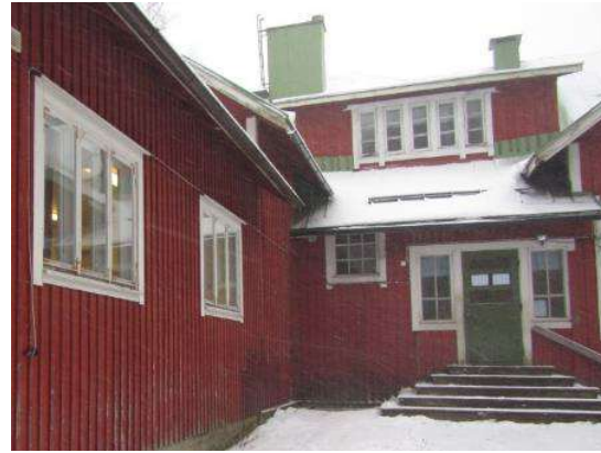
Kuva 50. Pääsisäänkäynnin yläpuolella on lumiesteet.
