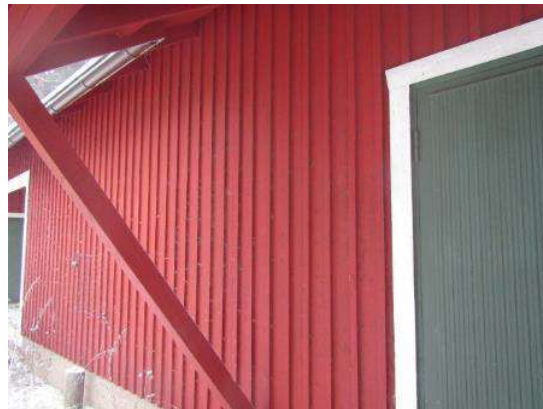
Kuva 10. Piharakennuksen maalipinnat ovat hyväkuntoisia.
