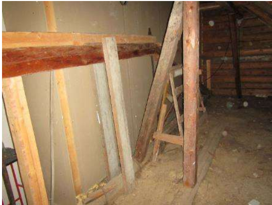
Kuva 25. Ullakon toista vetotankoa on paranneltu. Vetotanko vaikutti stabiililta. Muutama korjausosa oli tarpeeton, sillä ne eivät ottaneet mekaanista rasitusta vastaan.
