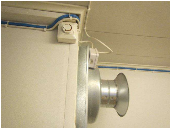
Kuva 79. Tilaan asennettu poistoilmapuhallin ja poistoilmäsäleikkö
