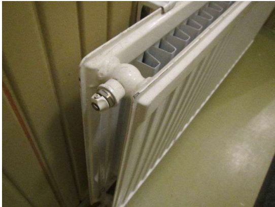
Kuva 67 Uusittu teräslevypatteri
