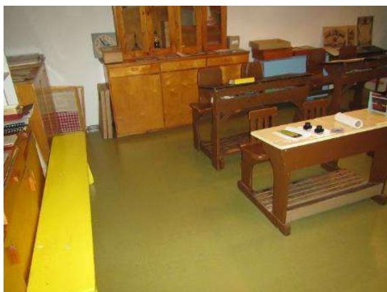
Kuva 53. Pinnat ovat yleisesti ehjiä, mutta vanhassa asussa.
