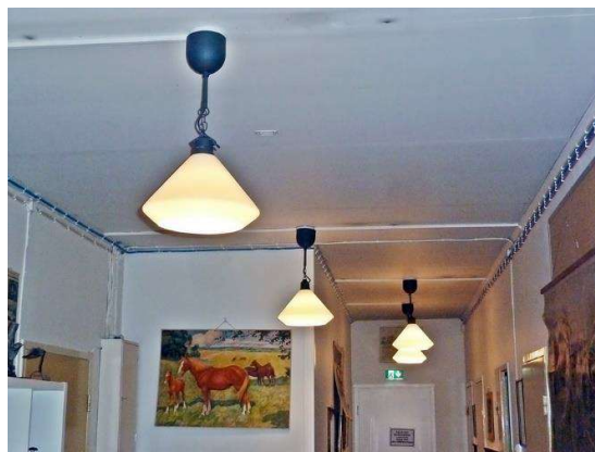
Kuva 93 LED CORN-ampulla päivitettävissä olevia valaisimia
