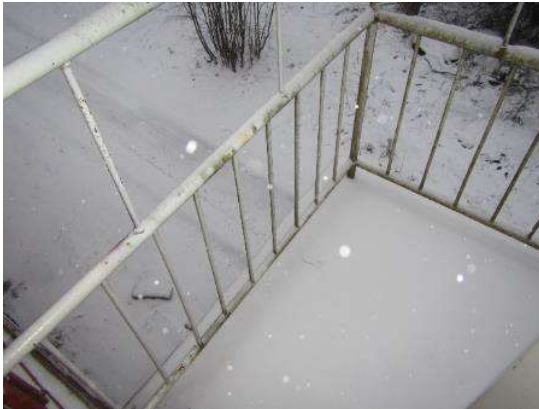
Kuva 39. Parveke ylhäältä päin kuvattuna.
