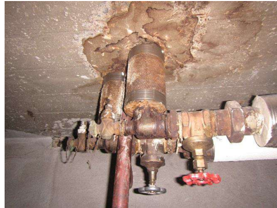
Kuva 68 Lämmitysverkoston nousujohdot
