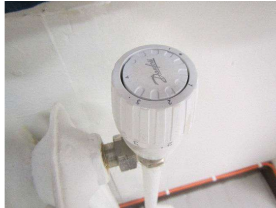
Kuva 66. Uudempi termostaattinen patteriventtiili
