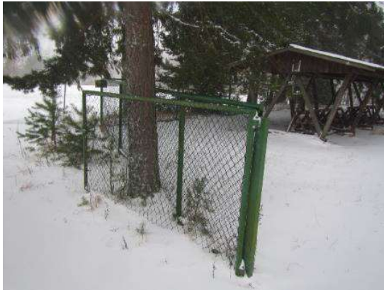
Kuva 8. Teräsrakenteiset aidat olivat tyydyttävässä kunnossa, vaurioita ei havaittu.
