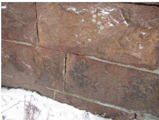
Kuva 11. Makkarasaumat ovat varisseet pois.
