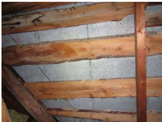
Kuva 45. Vesikatteenä on harvalaudoituksen päälle tehty konesaumattu peltikate.
