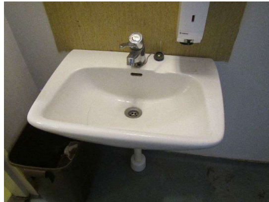
Kuva 72 Allashanoja on uusittu tarpeen mukaan
