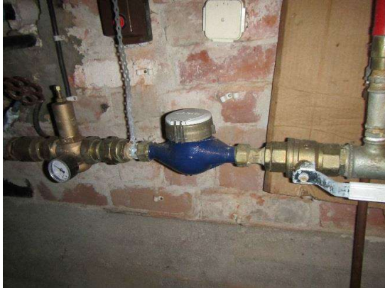
Kuva 69. Päävesimittari
