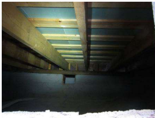
Kuva 16. Laajennusosan alapohjarakenteet olivat hyväkuntoisia.
