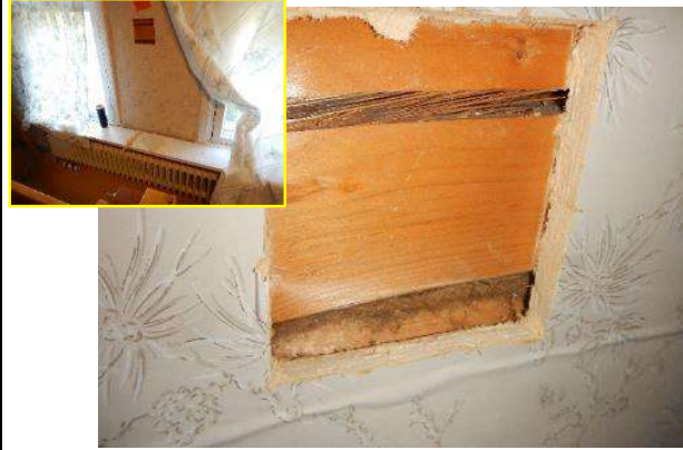
Taulukko 31. Ulkoseinän rakennevaus RA30 2.krs kangaspuut 3 –tilassa.
