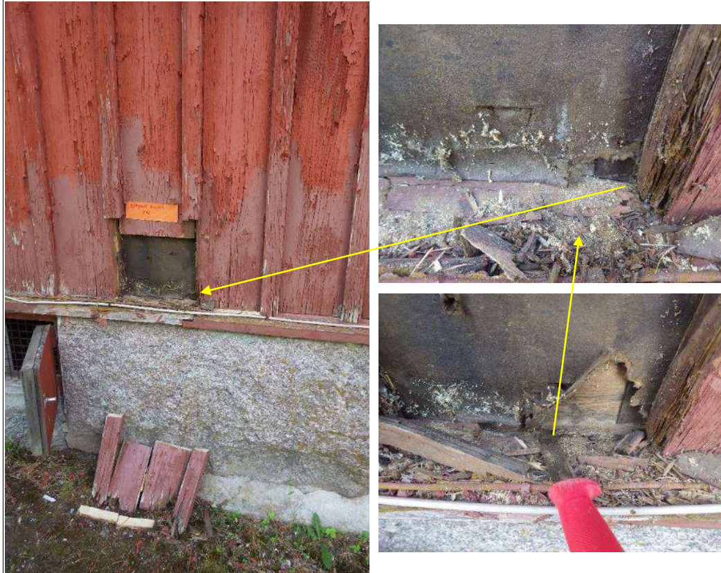
Taulukko 36. Ulkoseinän rakenneavaus RA36 länsijulkisivulla.
