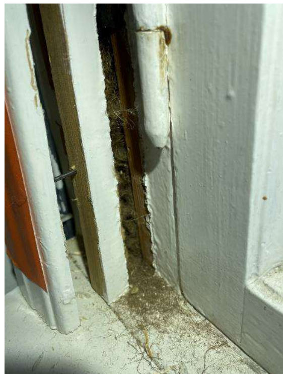
Taulukko 22. Ikkunaliittymän rakenneavaus RA11 tilassa ompelu, 1.krs.
