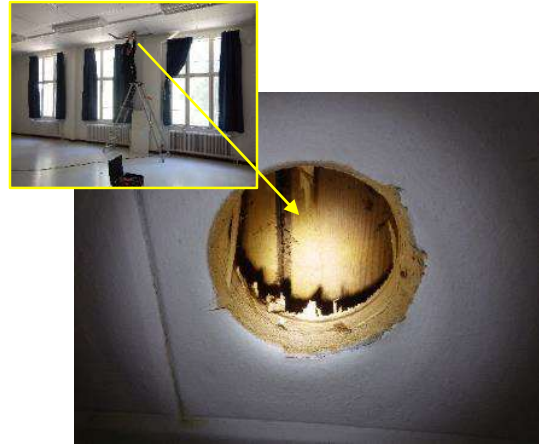
Taulukko 40. Yläpohjarakenteen rakenneavaus RA14 salin kattoon kosteusvaurioituneen akustolevyn kohdalle.
