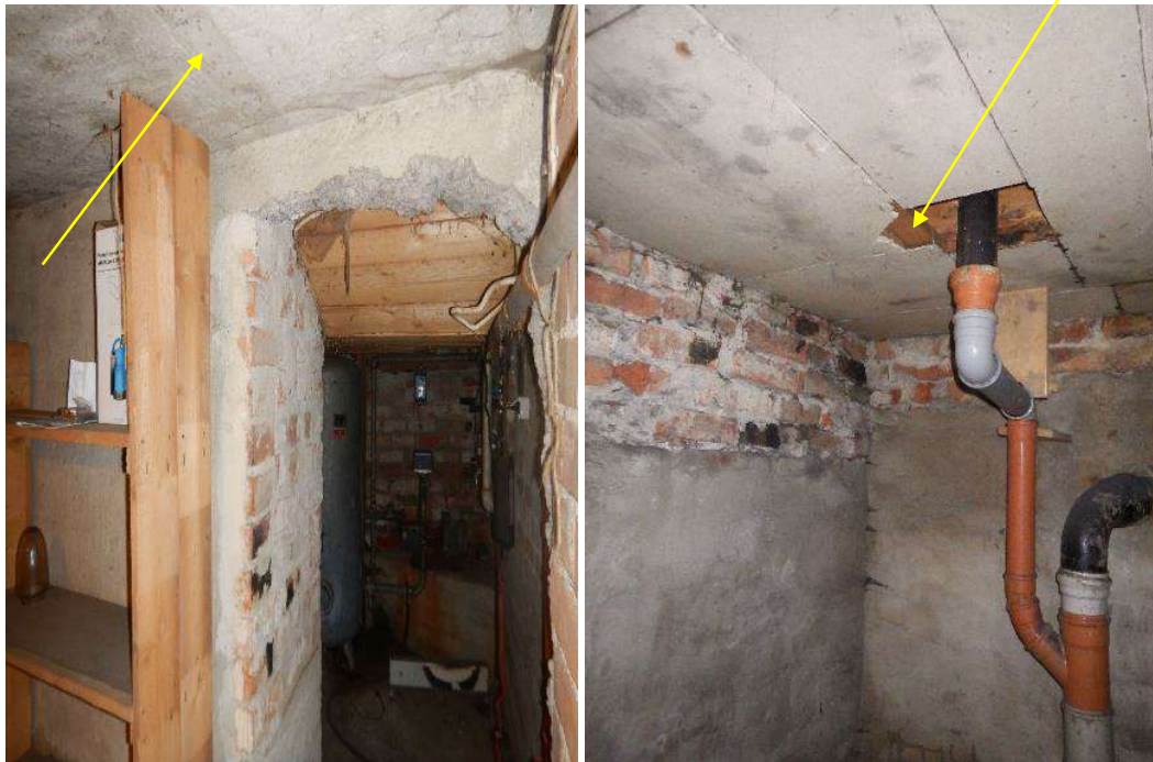
Kuva 19. Kellarin katon välipohjarakenteita. Ulkoseinän viereisen perunakellarin kohdalla katto on betonirakenteinen ja sen kantavana rakenteena ovat havaintojen perusteella ratakiskot. Öljysäiliötilan puurakenteisen katon alapinnassa on asbestipitoinen mileriittilevytys. levyt ovat paikoin rikki.
