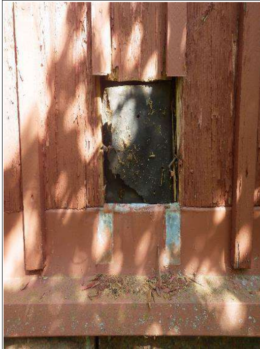
Taulukko 35. Ulkoseinän rakenneavaus RA35 eteläjulkisin kellarin kohdalla.
