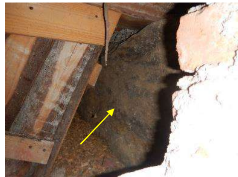
Taulukko 18. Kellarin ulkoseinän rakenneavaus RA3 seinärakenteen kunnan selvittämiseksi.
