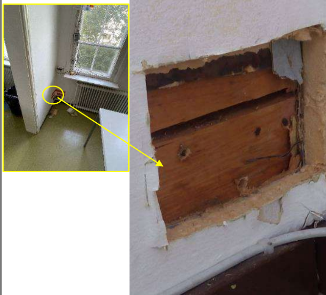
Taulukko 21. Väliseinän rakenneavaus RA12 tilassa ompelu.
