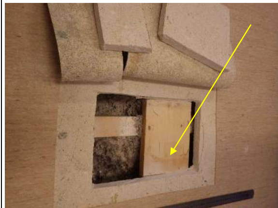
Taulukko 6. Laajennusosan luokkahuoneen lattiaan tehtiin alapohjarakenteen rakennearvaus RA16 alapohjarakenteen kunnan selvittämiseksi.
