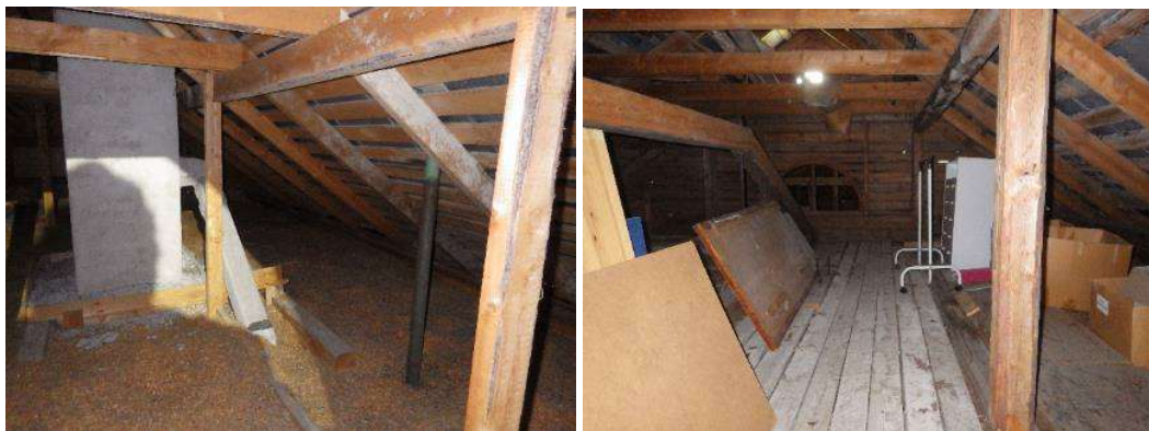
Kuva 32. Yleiskuvat laajennusosan sekä salin päällä olevasta kylmästä ullakosta.
