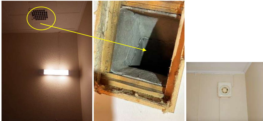
Kuva 44.. Laajennusosan vanhassa wc-tilassa on poistoilmaritilä, josta kuitenkin havaittiin voimakas ilmavirtaus käyttötiloihin päin. Poistoilmakanava on todennäköisimmin asbestipitoinen ja se liittyy ullakolla tehdyn havainnon mukaan vanhaan tiilihormiin. Laajennusosan nurkkahuoneessa (entinen keittiö/teknisen työn tila) on poistoilmaelin vanhan hormiin.
