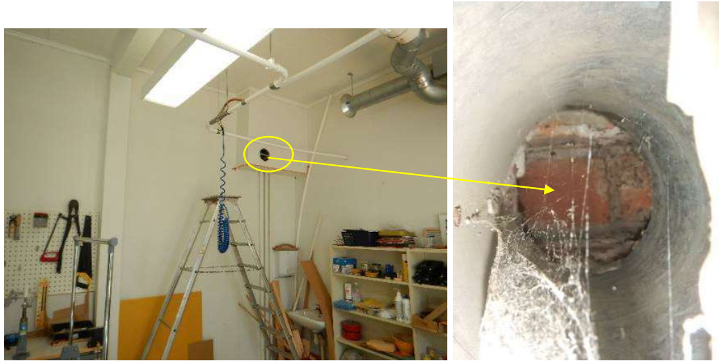
Kuva 39. Keittiön vieressä olevan huonekaluverhoilutilan nurkassa on vanha hormi. Hormin on vanha poistoilmaventtiili, jonka kohdalla ei ole kuitenkaan ilmavirtausta merkisavulla havaittuna. Venttiilin poiston jälkeen todettiin iv-putken päätyvän tiilimuuraukseen.
