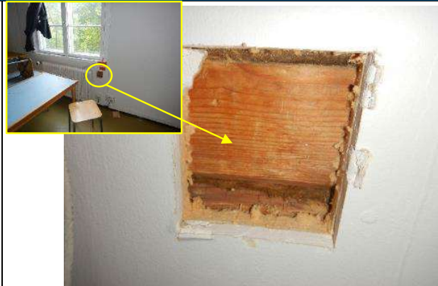
Taulukko 27. Ulkoseinän rakenneavaus RA13 tilassa ompelu.
