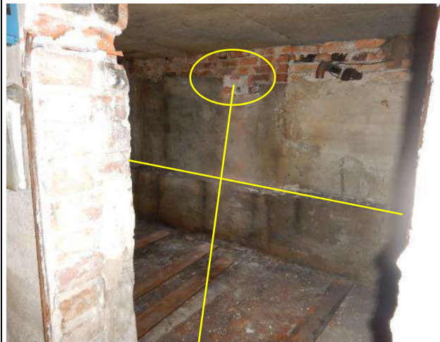
Taulukko 18. Kellarin ulkoseinän rakenneavaus RA3 seinärakenteen kunnan selvittämiseksi.
