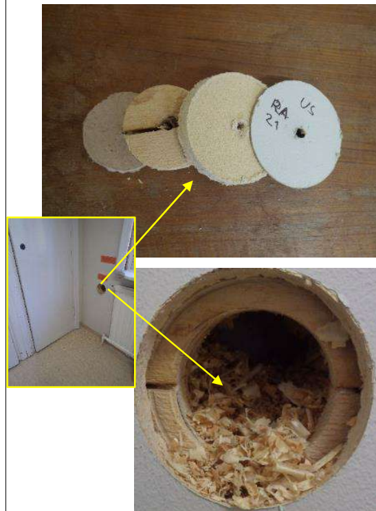
Taulukko 29. Ulkoseinän rakenneavaus RA21 laajennusosan nurkkaahuoneessa.
