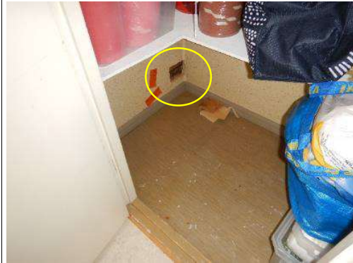
Taulukko 32. Ulkoseinän rakenneavaus RA31 2.krs nurkkakomero.
