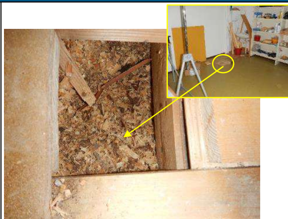
Taulukko 10. Puukattoisen perunakellarin ja huonekaluverhoilutilan välipohjarakenteeseen tehtiin rakenneavaus RA7 välipohjarakenteen kunnan selvittämiseksi.
