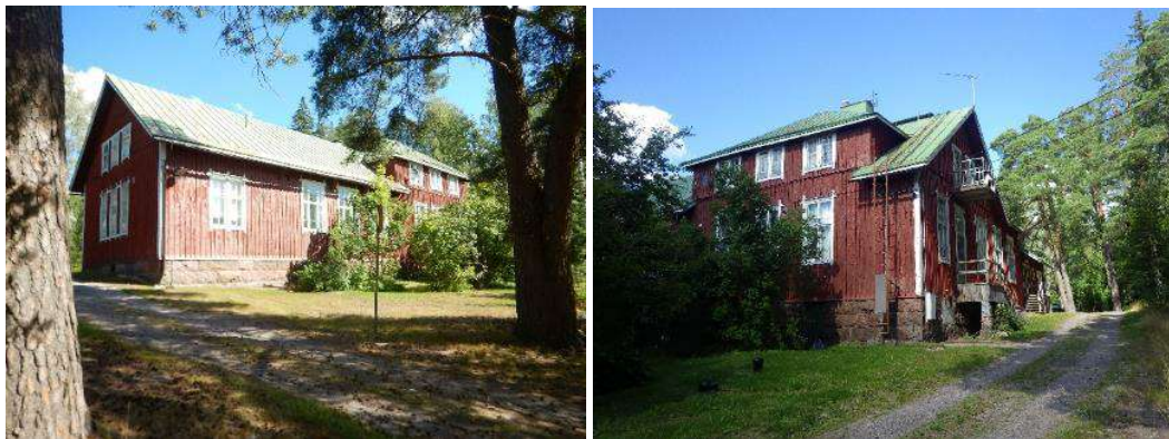
Kuva 12. Valokuvat rakennuksen eteläjulkisivusta lounaasta ja kaakosta kuvattuna.
