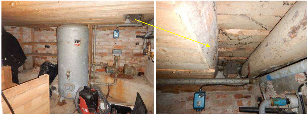
Kuva 20. Kellarikerroksen takimmaisessa perunakellarissa on myös puukatto, jonka kantavana rakenteena ovat puupalkit.
