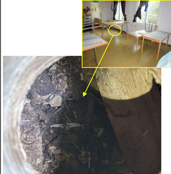
Taulukko 9. Betonikattoisen perunakellarin ja huonekaluverhoilutilan välipohjarakenteeseen tehtiin rakenneavaus RA6A välipohjarakenteen kunnan selvittämiseksi.
