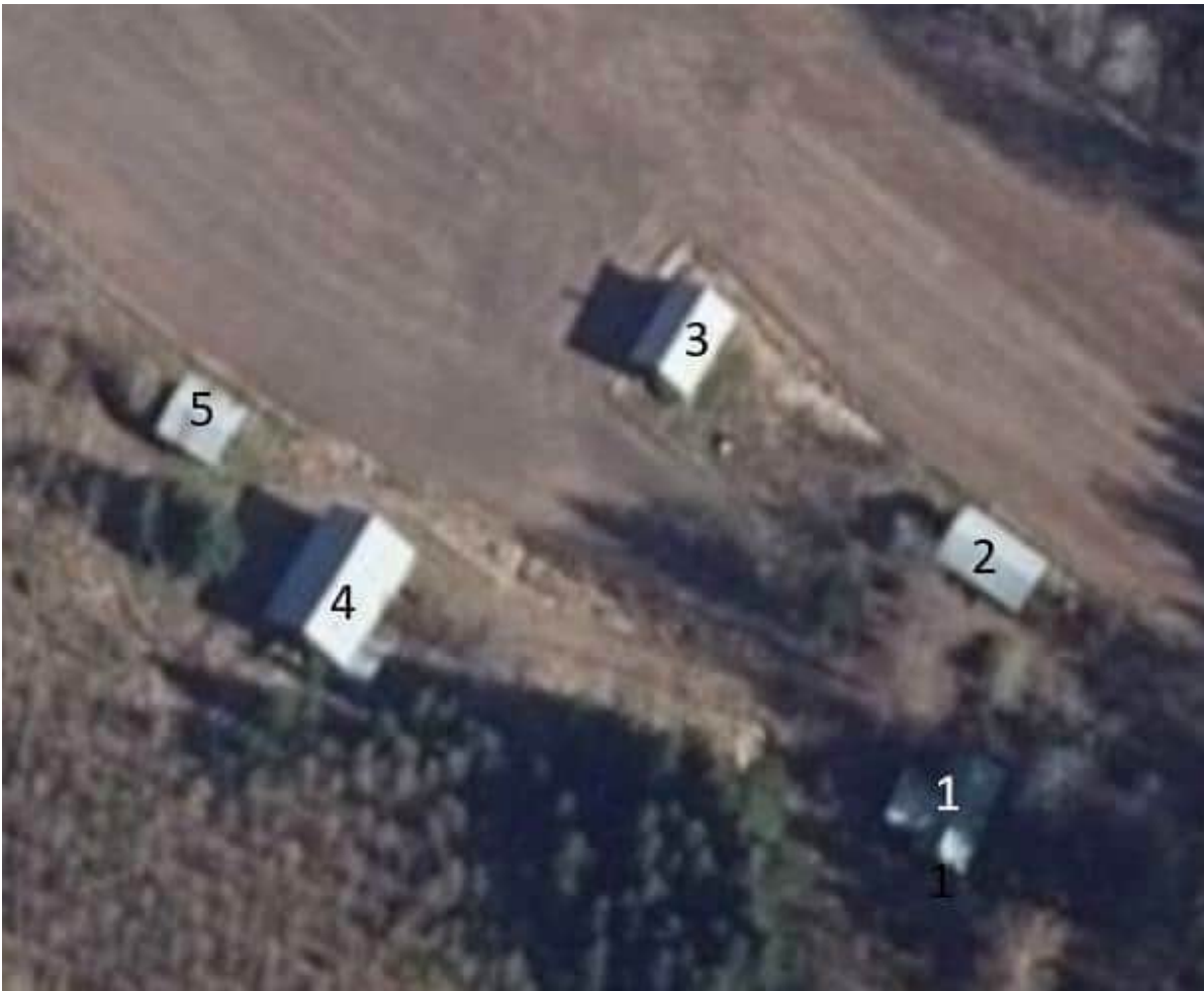
Kuva 15. Tarkastetut rakennukset: asuinrakennus (1), vaja (2), riihi (3), navetta (4) ja vaja (5).
