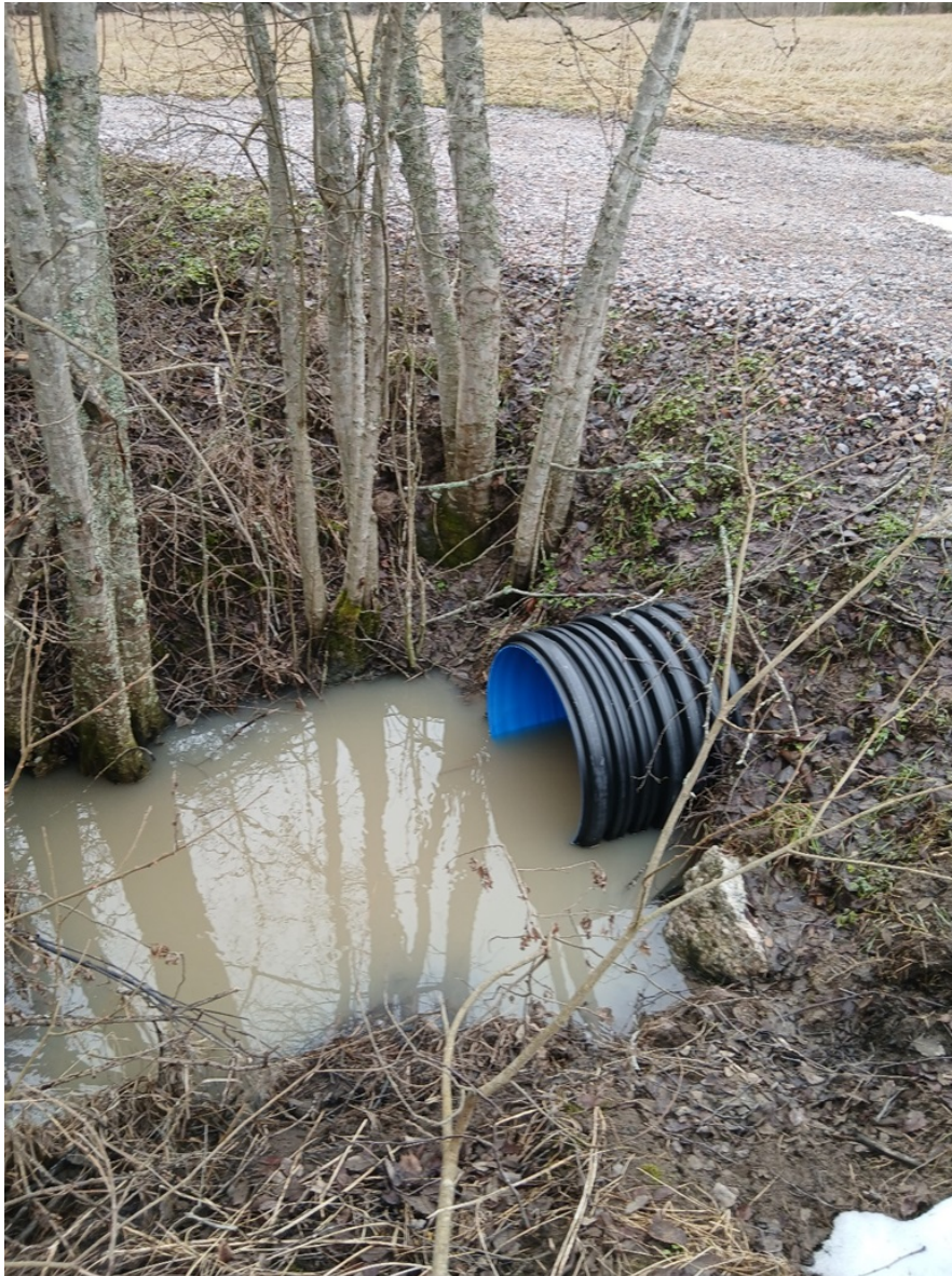
kuva 3. Ulkoilureitin uusi siltarumpu alajuoksun puolelta, 6.3.2025
