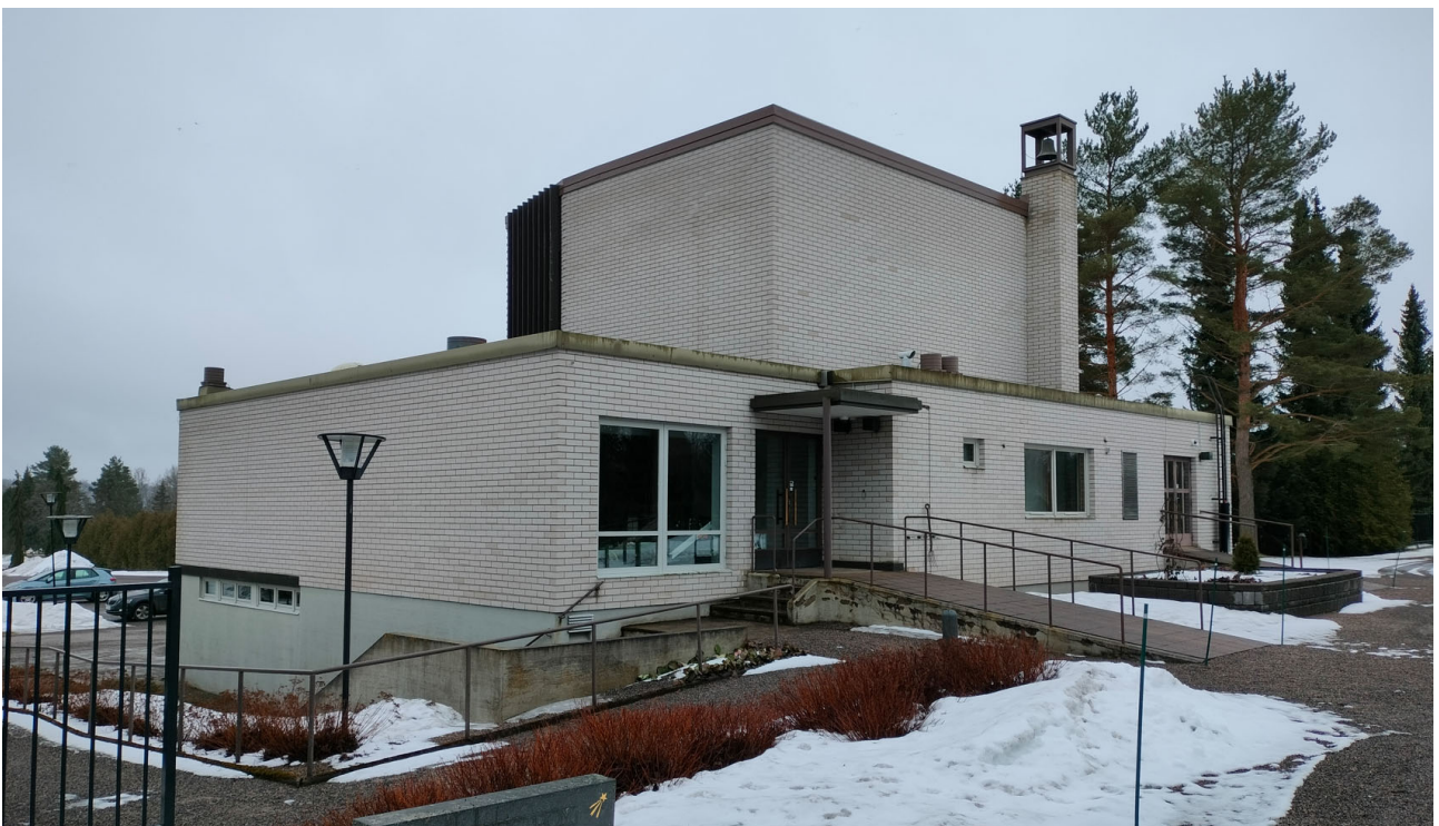
Rakennus pohjoisesta hautausmaan suunnasta.
