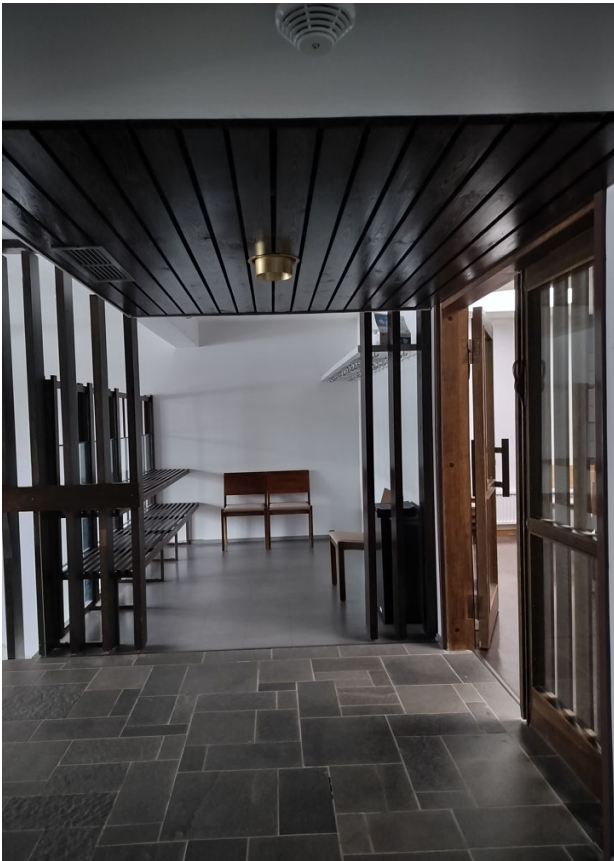
Yläkerran aulatilaa tehty naulakkolaajennus. Erilainen lattiamateriaali erottaa laajennuksen alkuperäisestä lattiapinnasta.
