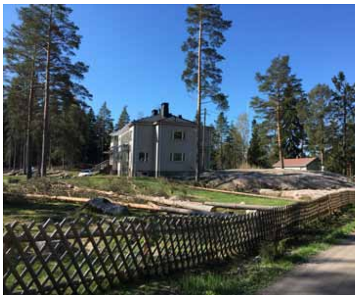
Västerskogin kyläkeskittymän ajallisesti kerrostunutta rakennuskantaa.
