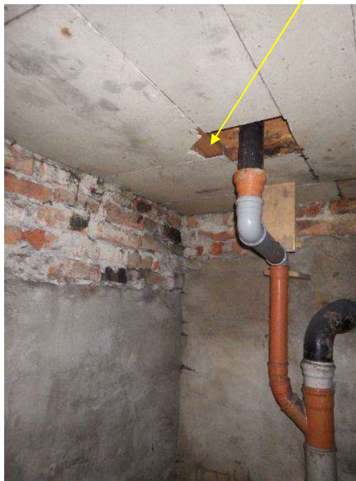
Kuva 19. Kellarin katon välipohjarakenteita. Ulkoseinän viereisen perunakellarin kohdalla katto on betonirakenteinen ja sen kantavana rakenteena ovat havaintojen perusteella ratakiskot. Öljysäiliötilan puurakenteisen katon alapinnassa on asbestipitoinen määrittelytys. levyt ovat paikoin rikki.
