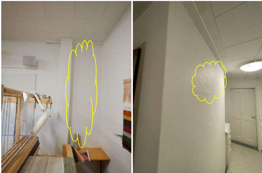
Kuva 26. Toisen kerroksen keittiön, käytävän ja kangaspuut 1 –tilojen nurkkauksessa olevan tiilihormin seinäpinnoilla on kosteuden aiheuttamaa maalipinnan kupruilua. Kupruilukohdista todettiin muita hormi- ja seinäpintoja korkeampia pintakosteusilmai- simen vertailuarvoja, lukemien vaihdellessa välillä 90...110, vertailuarvon ollessa 50.
