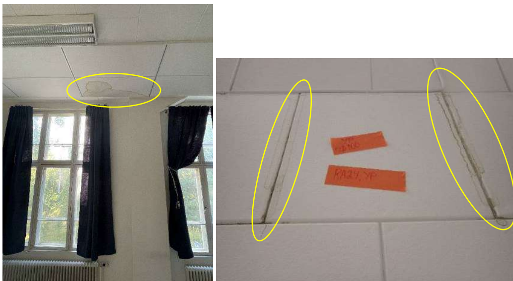
Kuva 34. Salin katon akustolevyssä havaittiin vesivuotojälkiä kutakuinkin kattojiirin alapuolella. Toisen kerroksen kangaspuutilassa 2 havaittiin kattolevytyksessä vesivuotojälkiä.
