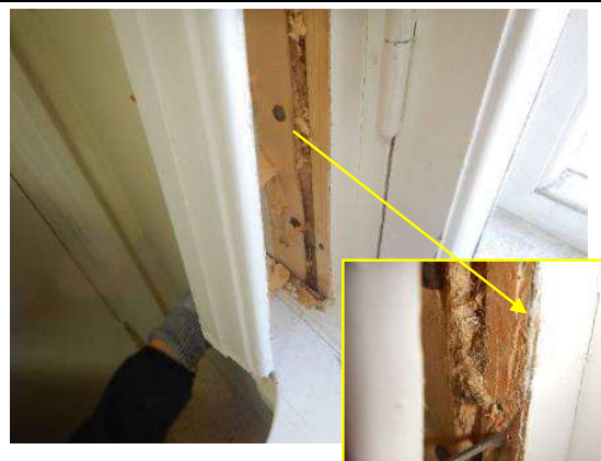
Taulukko 25. Ikkunaliittymän rakenneavaus RA29 toisen kerroksen toimitiloiksi muute- tussa entisessä asunnossa.
