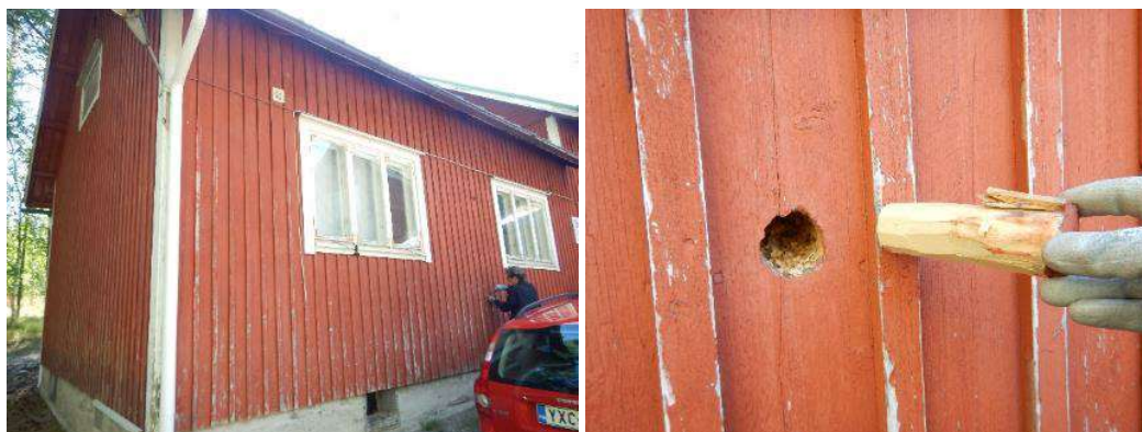
Kuva 22. Laajennusosan luokkahuoneen ikkunoiden välissä on ilmeisesti vanha tapilla suljettu rakenneavauskohta. Rakenne tapin kohdalla on seuraava: lauta ~24 mm – ter- vapahvi – lauta ~24 mm – pahvi –puru ~100 mm.
