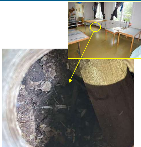
Taulukko 9. Betonikattoisen perunakellarin ja huonekaluverhoilutilan välipohjarakenteeseen tehtiin rakenneavaus RA6A välipohjarakenteen kunnon selvittämiseksi.
