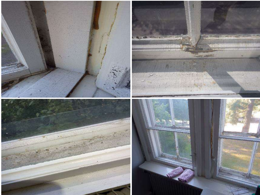
Kuva 24. Ikkunavälien maalipinta on huonokuntoinen ja ulkopuitteissa on alkavaa lahoa. Ikkunaväleissä on paikoin pölyä ja likaa. Joidenkin tilojen ikkunaliittymistä oli havaittavissa voimakasta ilmavuotoa. Käyttäjät ovat tilkinneet ikkunaliittymiä paperilla ja teippauksilla. Osaa ikkunoista on vaikea avata ja sulkea.
