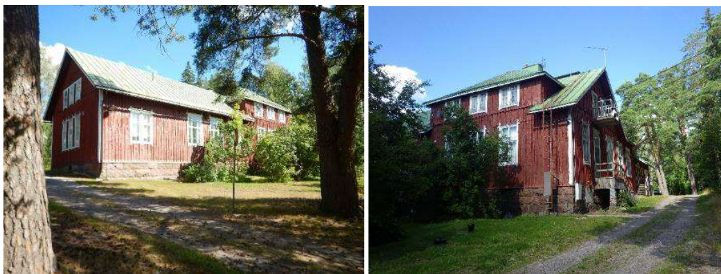
Kuva 12. Valokuvat rakennuksen eteläjulkisivusta lounaasta ja kaakosta kuvattuna.
