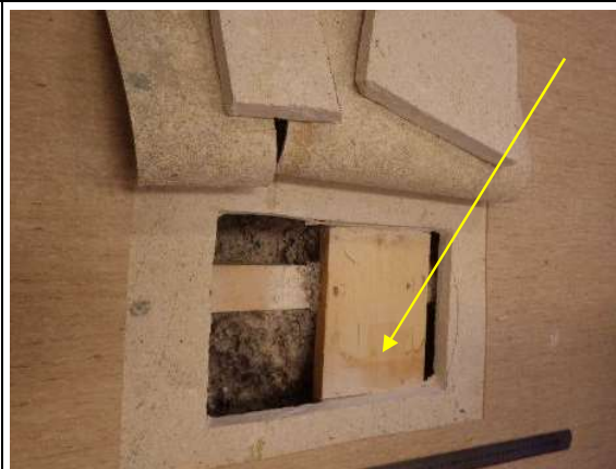
Taulukko 6. Laajennusosan luokkahuoneen lattiaan tehtiin alapohjarakenteen rakenneavaus RA16 alapohjarakenteen kunnon selvittämiseksi.
