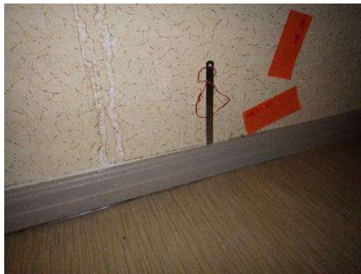
Kuva 18. Välipohjarakenteen sisäkuori ei ole ilmatiivis kummassakaan kerroksessa. Selviä rakoja havaittiin etenkin seinä-lattialiittymissä. Vasen kuva on käyttökiellossa olevan parvekkeen kynnyksen liittymästä ja oikea kuva pienestä komerosta vesikaton jirrin kohdalla. Seinän tapetissa on vesivuotojälkiä.
