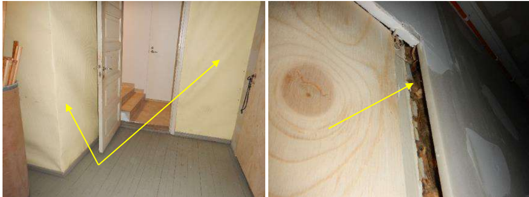
Kuva 27. Toisen kerroksen länsipuolen portaikon yläosassa olevassa aulassa ovat seinien vanhat pinkopahvit kuprulla, samoin aulan viereisen varaston väliseinässä. Varastoon ja kangaspuut-tilaan on asennettu vaneriovet, joiden liittymistä ovat näkyvissä hirsiväliseinien riveet.
