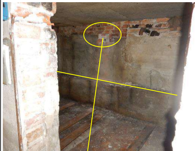
Taulukko 18. Kellarin ulkoseinän rakenneavaus RA3 seinärakenteen kunnon selvittämiseksi.
