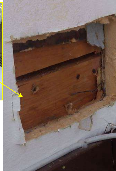
Taulukko 21. Väliseinän rakenneavaus RA12 tilassa ompelu.
