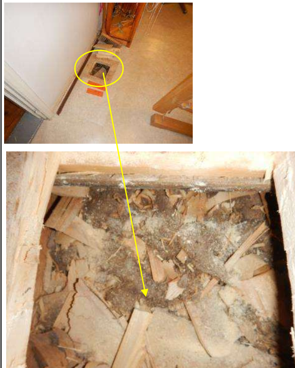
Taulukko 12. Toisen kerroksen käytävälle tehtiin välipohjarakenteen rakenneavaus RA23 välipohjarakenteen kunnon selvittämiseksi.
