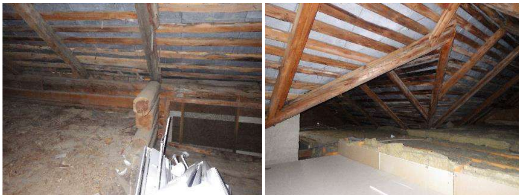
Kuva 33. Yleiskuvat eteläjulkisivun puolella olevasta kylmästä ullakosta. Ullakolta näkee helposti yläpohjarakenteessa tapahtuvan korkotasoeron. Ullakolle myöhemmin rakennetun asunnon levyrakenteet ovat myös näkyvissä.
