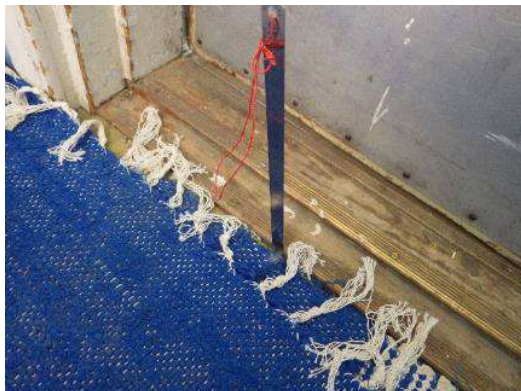
Kuva 18. Välipohjarakenteen sisäkuori ei ole ilmatiivis kummassakaan kerroksessa. Selviä rakoja havaittiin etenkin seinä-lattialiittymissä. Vasen kuva on käyttökiellossa olevan parvekkeen kynnyksen liittymästä ja oikea kuva pienestä komerosta vesikaton jirrin kohdalla. Seinän tapetissa on vesivuotojälkiä.
