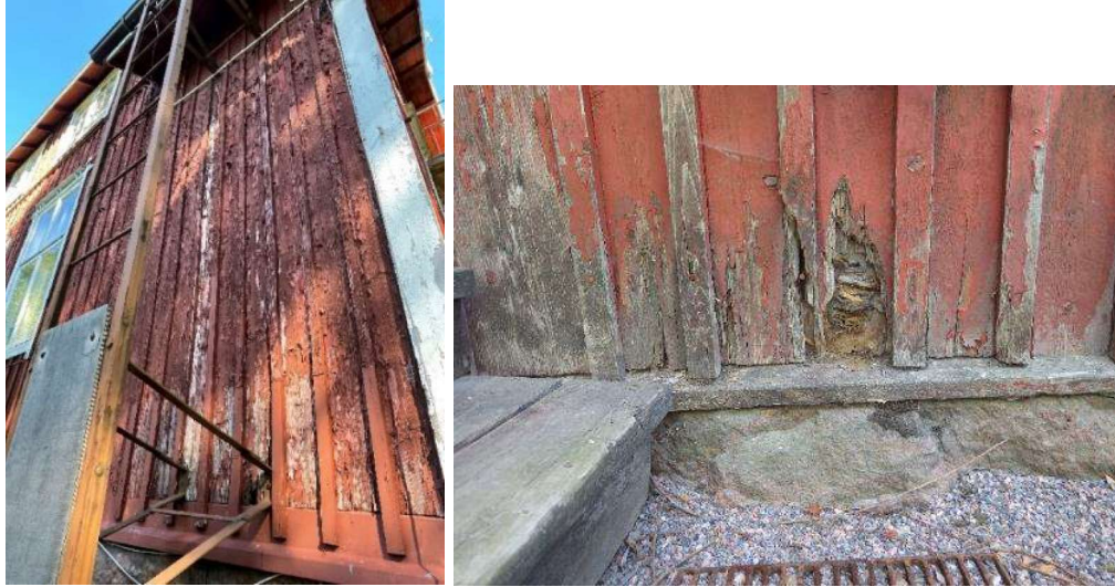
Kuva 23. Seinien alaosien julkisivulaudoituksen ja hirsien lahoaminen on paikoin näkyvissä ilman rakenneavauksia, kuten kattotikkaiden ja pääsisäänkäynnin portaiden kohdalla.
