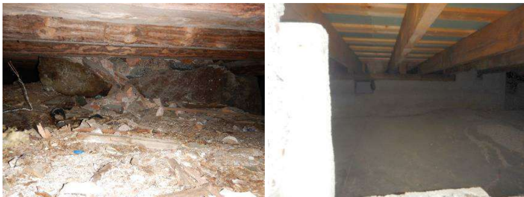
Kuva 16. Alkuperäisen osan länsijulkisivun keskellä sokkelissa olevan ryömintätilan kulkuaukosta havaittiin ryömintätilan pohjamaan päällä rakennusjätettä. Laajennusosan uusitun alapohjan siistikuntoisen ryömintätilan pohjalle on asennettu suodatinkangas.
