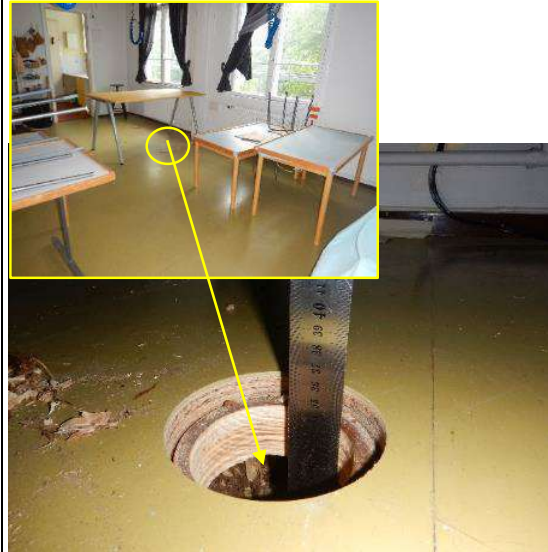
Taulukko 12. Toisen kerroksen käytävälle tehtiin välipohjarakenteen rakenneavaus RA23 välipohjarakenteen kunnon selvittämiseksi.
