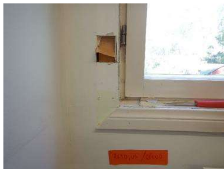
Taulukko 25. Ikkunaliittymän rakenneavaus RA29 toisen kerroksen toimitiloiksi muute- tussa entisessä asunnossa.
