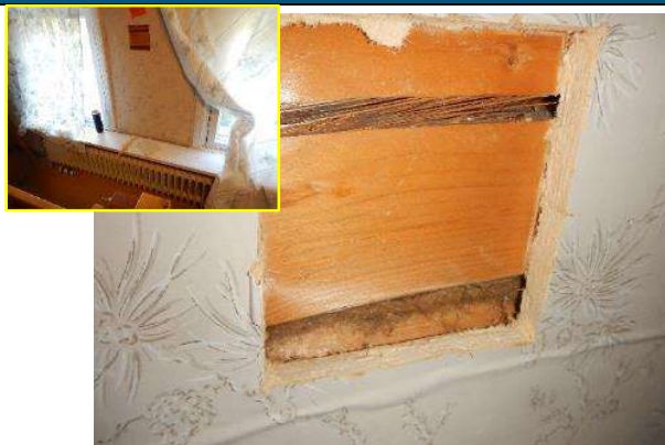
Taulukko 31. Ulkoseinän rakennevaus RA30 2.krs kangaspuut 3 –tilassa.
