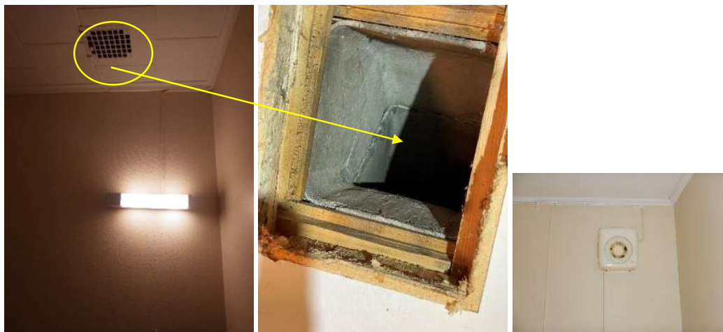
Kuva 44.. Laajennusosan vanhassa wc-tilassa on poistoilmariitä, josta kuitenkin ha- vahtiin voimakas ilmavirtaus käyttötiloihin päin. Poistoilmakanava on todennäköisim- min asbestipitoinen ja se liittyy ullakolla tehdyn havainnon mukaan vanhaan tiilihormiin. Laajennusosan nurkkahuoneessa (entinen keittiö/teknisen työn tila) on poistoilmalelin vanhan hormiin.
