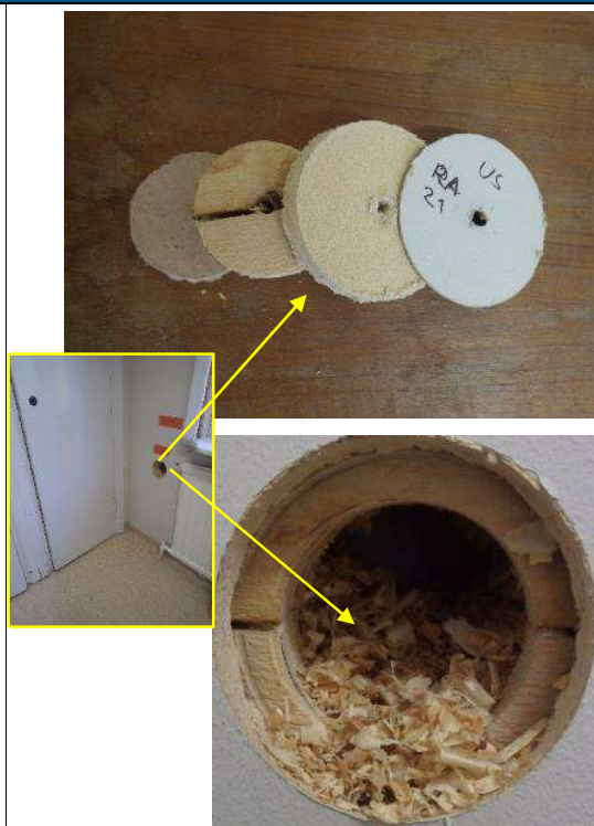
Taulukko 29. Ulkoseinän rakenneavaus RA21 laajennusosan nurkkahuoneessa.
