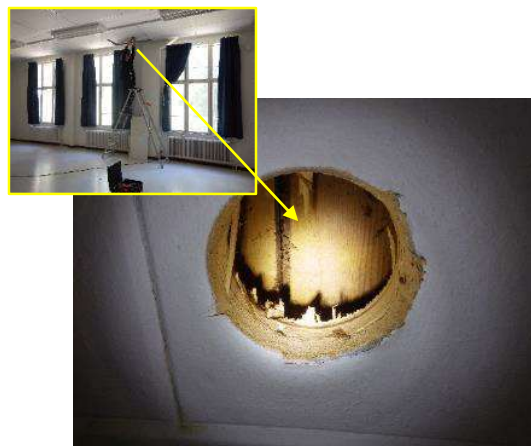
Taulukko 40. Yläpohjarakenteen rakenneavaus RA14 salin kattoon kosteusvaurioituneen akustolevyn kohdalle.
