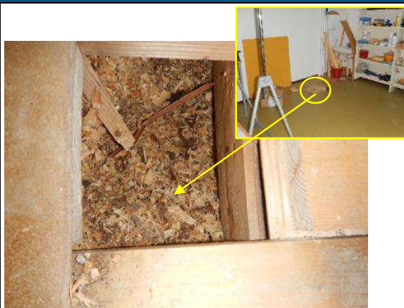
Taulukko 10. Puukattoisen perunakellarin ja huonekaluverhoilutilan välipohjarakenteeseen tehtiin rakenneavaus RA7 välipohjarakenteen kunnon selvittämiseksi.
