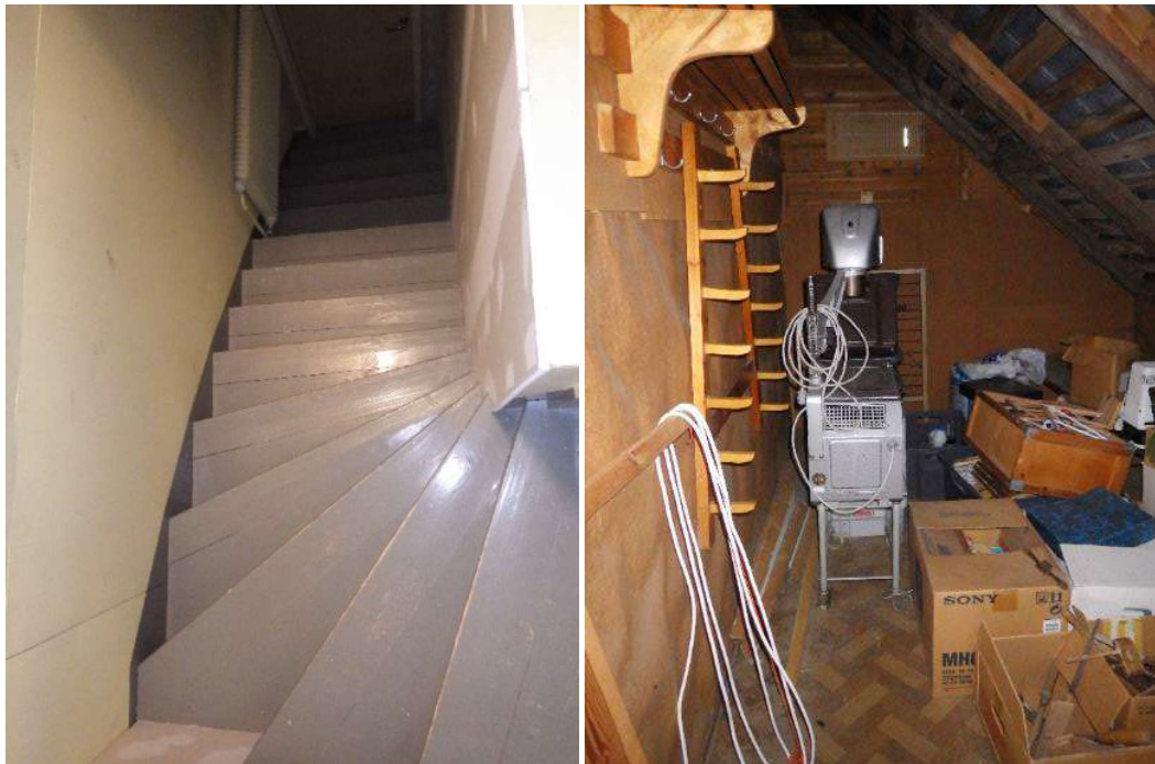
Kuva 28. Toisen kerroksen länsipuolen portaikossa on viimeistelemätöntä kipsilevyseinää. Yläaulasta on kulku kylmään varastoon. Varaston väliseinän pinnassa oleva pahvi kupruili kosteudesta, mutta hirsissä ei tuntunut lahoa.
