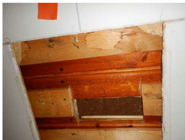
Taulukko 43. Yläpohjarakenteen rakenneavaus RA24 toisen kerroksen alkuperäiseen asunnon kattoon, nykyiseen kangaspuut 2 -tilaan.
