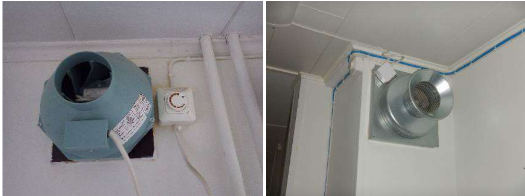
Kuva 41. Ompelutilassa on kanavapuhallin tuloilmalaitteena, joka kytkeytyy päälle samasta katkaisijasta kuin valot. Laajennusosan luokahuoneessa on kanavapuhallin poistoilmalaitteena, joka kytkeytyy päälle samasta katkaisijasta kuin valot.
