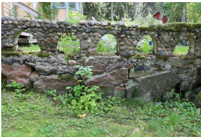
Oskar von Nandelstadin alun perin 1910-luvulla rakennuttaman saaristohuvilan muotopuutarhasta on säilynyt erikoisia kivipäällysteisiä betonirakenteita ja pengerryksiä.
