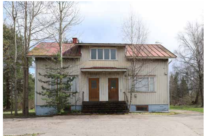
Boxin risteysalueella näkyvästi sijaitseva, alkuperäiset piirteensä hyvin säilyttänyt satulakattoinen, entinen liikerakennus 1950-luvulta.
