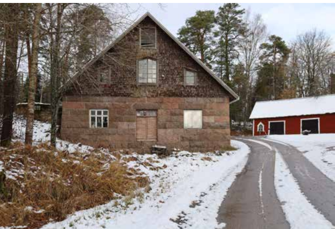
Hitän kartanon 1910-luvulla rakennetun navetan julkisivut on muurattu jäleistä graniittiharkoista, ullakkokerroksen pääty on verhottu ohuilla paanuilla.
