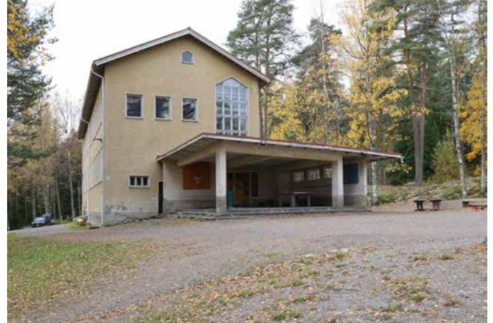
Salparin koulu edustaa 1950-luvun satulakattoista, rapattua koulurakennustyyppiä. Opetustila- ja asuntosiivet on sovitettu rinteeseen kulmittain.
