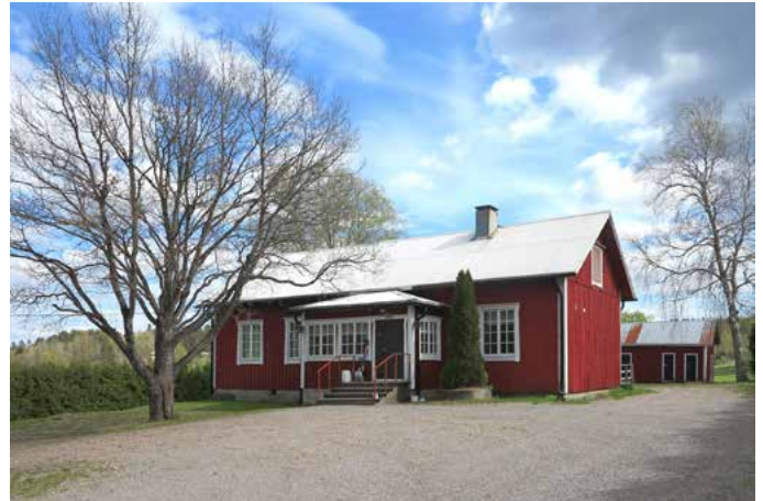
Hindsbyn kylätalo, Byagården on Bys-Martisin tilan entinen päärakennus, joka vuonna 1916 siirrettiin kylätontilta pikkukouluksi nykyiselle paikalleen.
