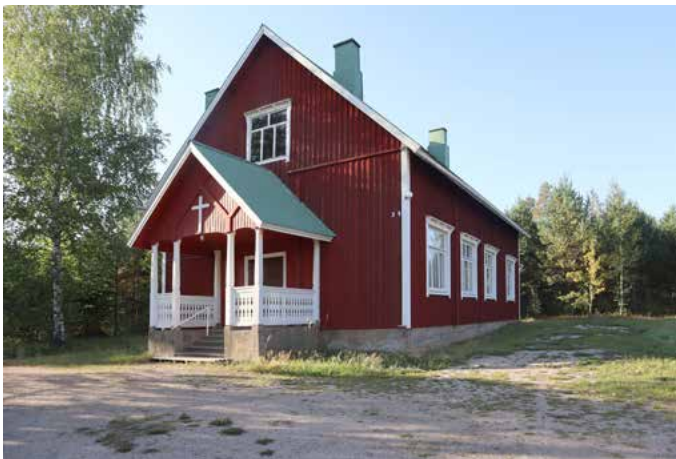
Pohjois-Paippisen kyläkirkko, asunsa hyvin säilyttänyt, seudulle tyypillinen, hirsirunkoinen, pystyrimavuorattu rukoushuonerakennus 1900-luvun alkupuolelta
