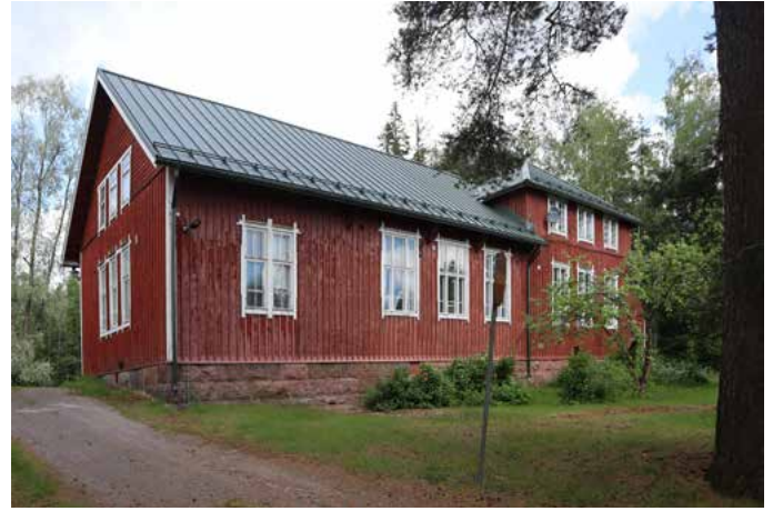
Entinen Talman kansakoulu, osittain kaksikerroksinen, hirsirunkoinen koulurakennus 1910-luvulta, jossa nykyisin toimii Sipoon Koulumuseo.
