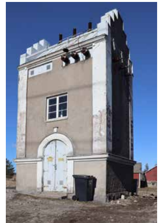
Brobörentien muuntajan ulkoasu porraspäättyaiheineen ja holvattuine portteineen tavoittelee monumentaalisuutta.
