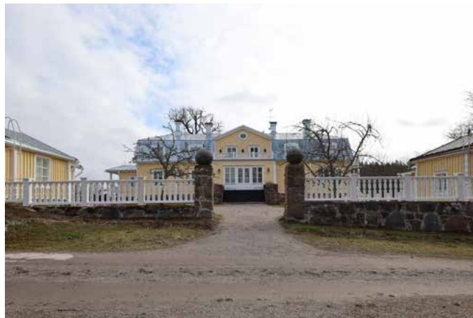
Eriksnäsän kartanon pää- ja siipirakennusten kehystämä aidattu piha. 1810-luvulta periytyvä päärakennus on korjattu 1916 arkkitehti Armas Lindgrenin suunnitelmien mukaan.
