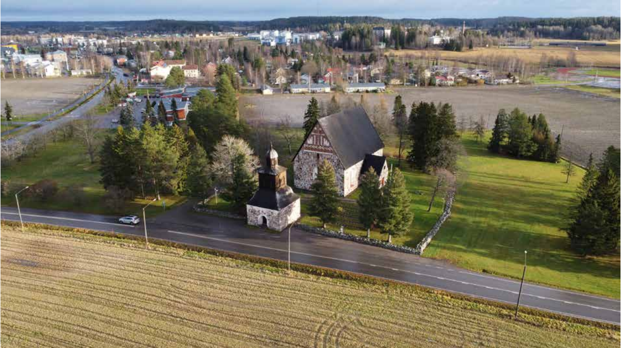
Nikkilä ja Sipoon vanha kirkko, joka sijaitsee vasemmalla näkyvän Suuren Rantatien ja Sipoonjoen risteyksen tuntumassa. Kuva Kari Mikkonen, Paikkatietokonsultit Oy.
