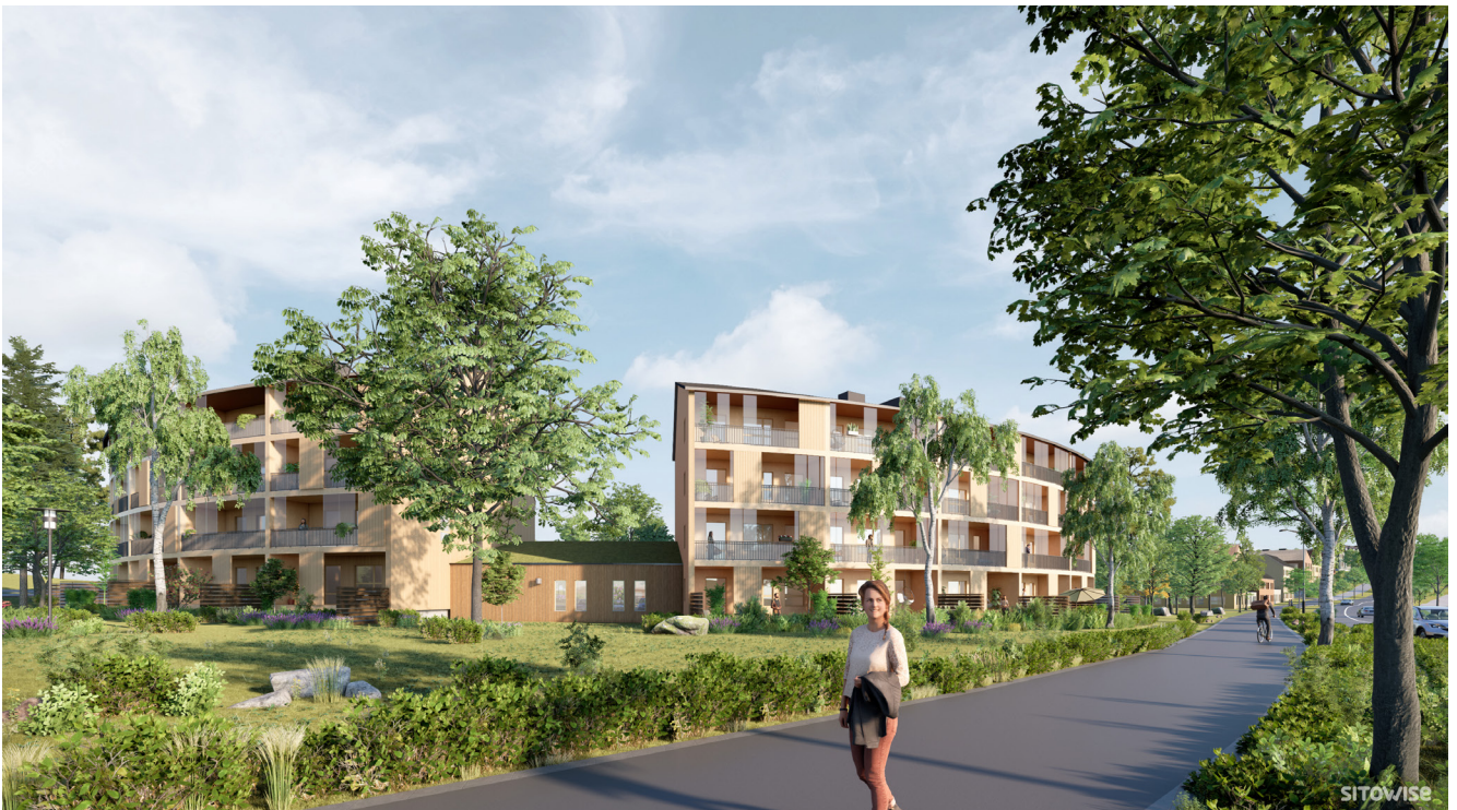
Puurakenteisia kerrostaloja korttelissa 31001. Flerbostadshus i trä i kvarter 31001.
