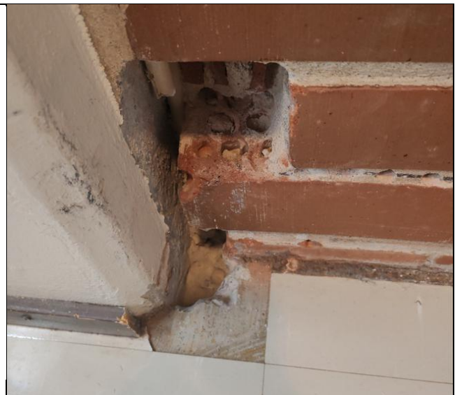
Kuva 12. Rakenneavaus väliseinän kohdalla. Väliseinä lähtee pintavalukerroksen alapuolelta.
