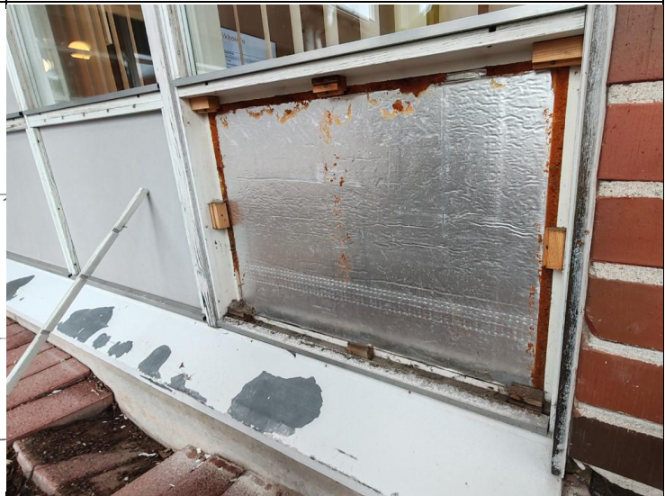
Kuva 5. Kevytrakenteisten ikkunanalituksien rakennetta. Lämmöneristeenä on alumiinipinnoitteinen uretaani. Uretaania ei rikottu rakenneavauksessa.
