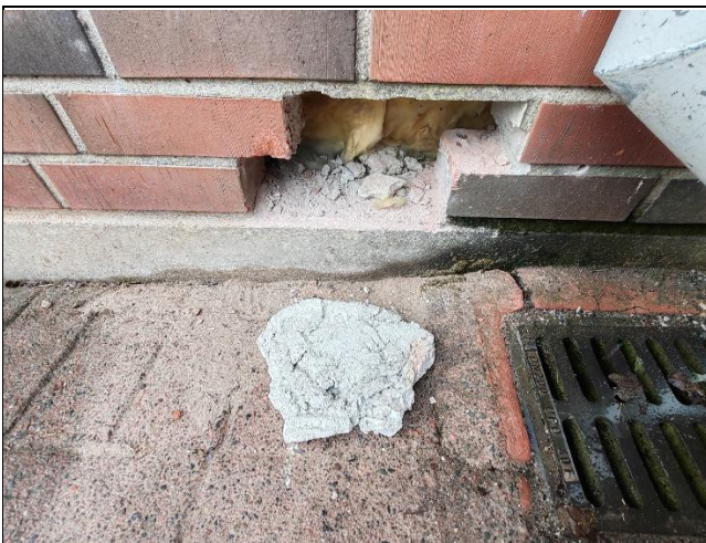
Kuva 8. Laastipurseita oli runsaasti. Ne muodostivat paikoin levymäisiä möykkyjä. Kuva luokan A1 kohdalta.
