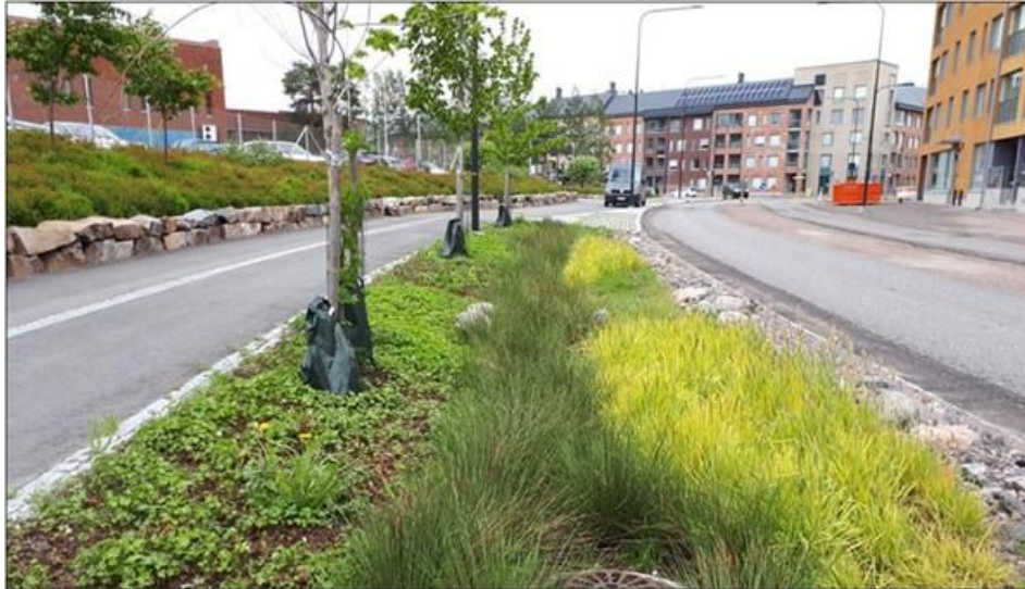
Kuva 17. Esimerkki biosuodatusrakenteesta (© Ramboll)
