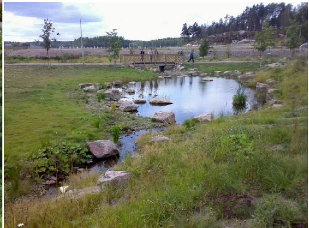
Kuva 14. Esimerkki hulevesipainanteesta (Ramboll) & esimerkki hulevesialtaasta (Hangon Kaupunki)
