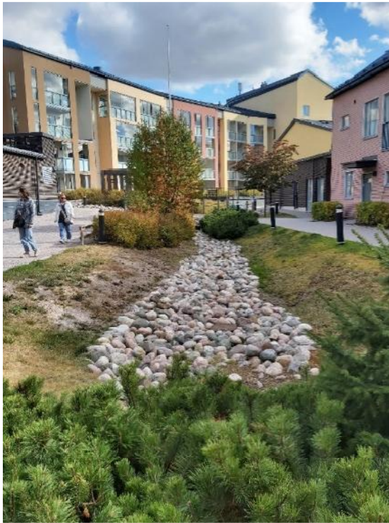
Kuva 14. Esimerkki hulevesipainanteesta (Ramboll) & esimerkki hulevesialtaasta (Hangon Kaupunki)
