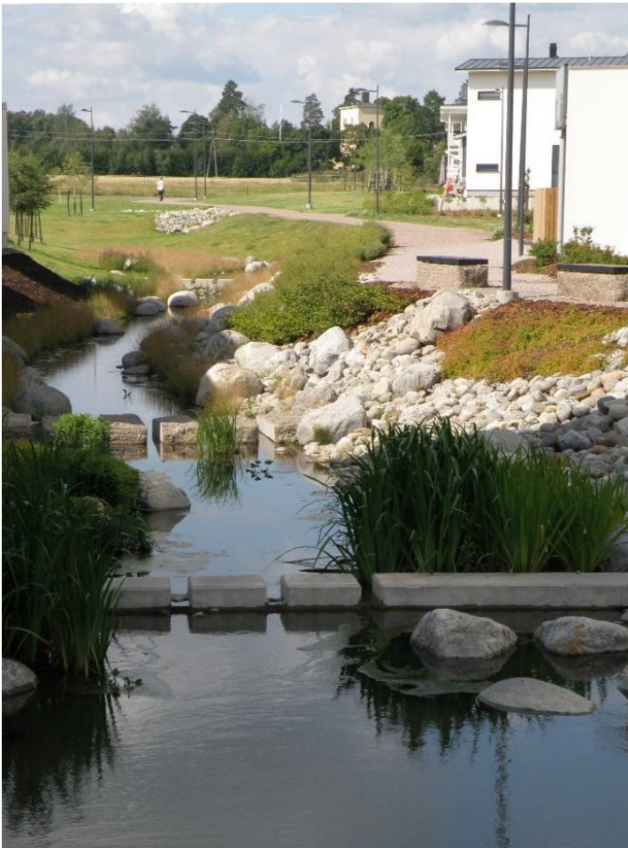
Kuva 16. Mutkitteleva avo-oja, jossa virtaamaa on hidastettu muotoiluilla, kasvillisuudella sekä pohjajäädöillä. (© Ramboll 2012)
